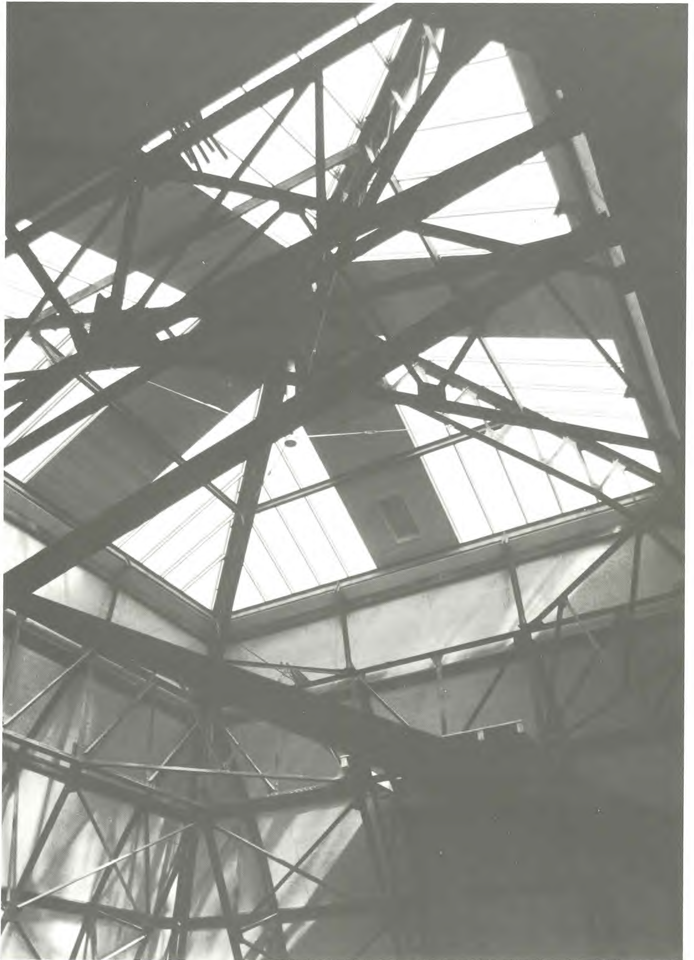
STAHL - HOLZ KONSTRUKTION DES SANIERTEN KUPPELRAUMES
