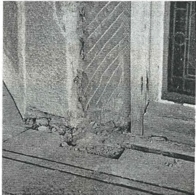
während der Sanierung
