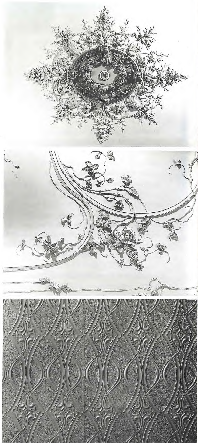
Oben und Mitte: Restaurierte Deckenstukkaturen nach der Renovation Unten: Restaurierte Wandbehandlung im Treppenhaus
