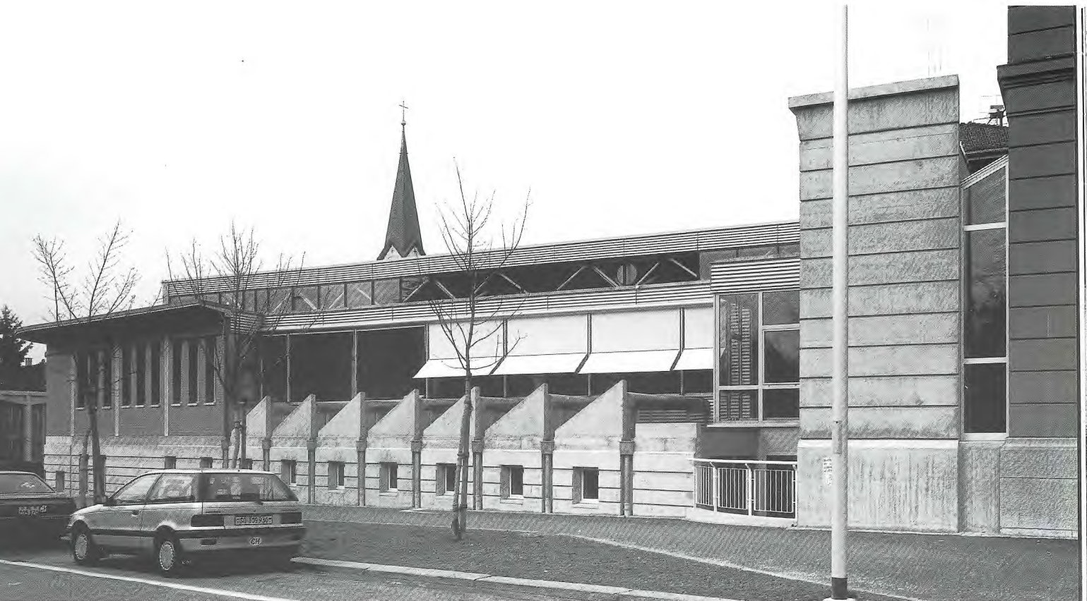
Erweiterungsbau Maschinenlabor. Fassade gegen Pestalozzistrasse mit Übergang zum Altbau M.
