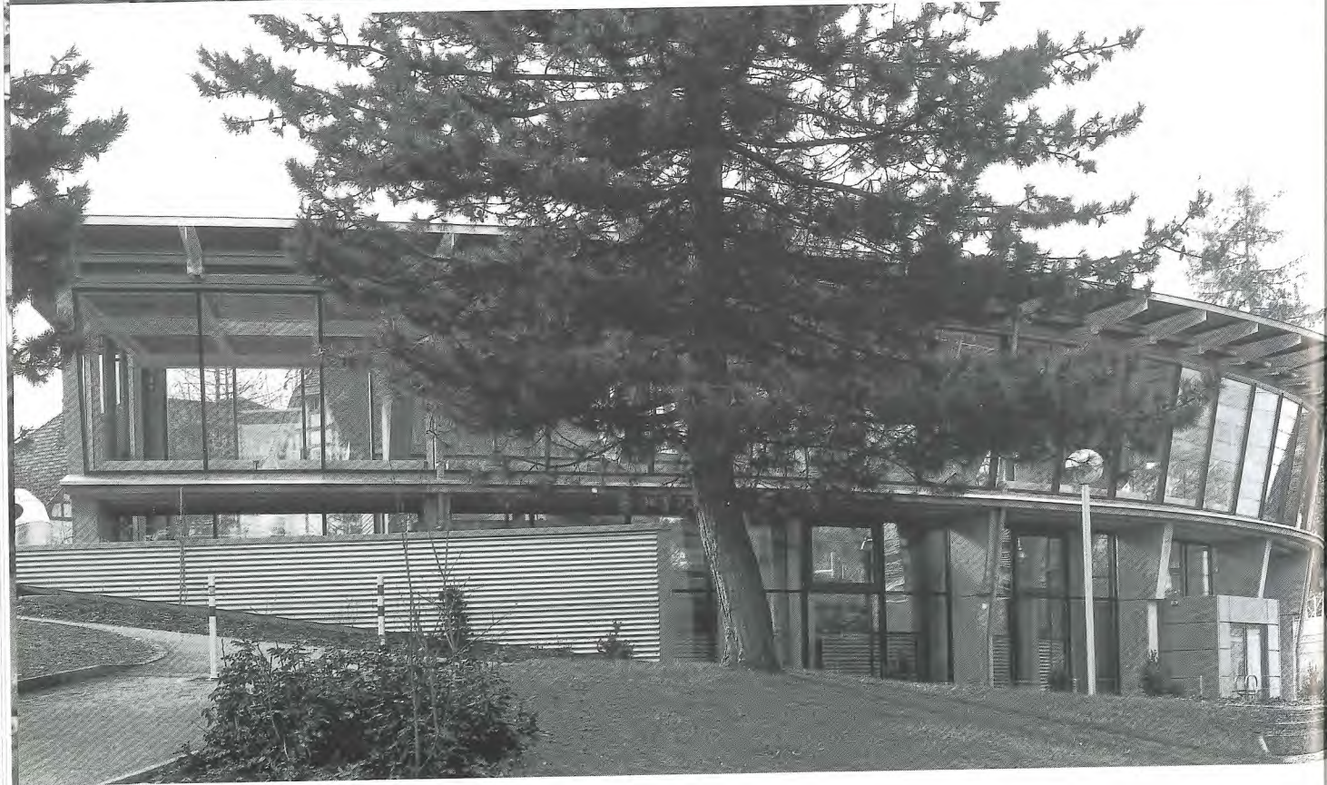
Ansicht Hörsaalgebäude, fotografiert von der Nordost- ecke des Altbaus E
