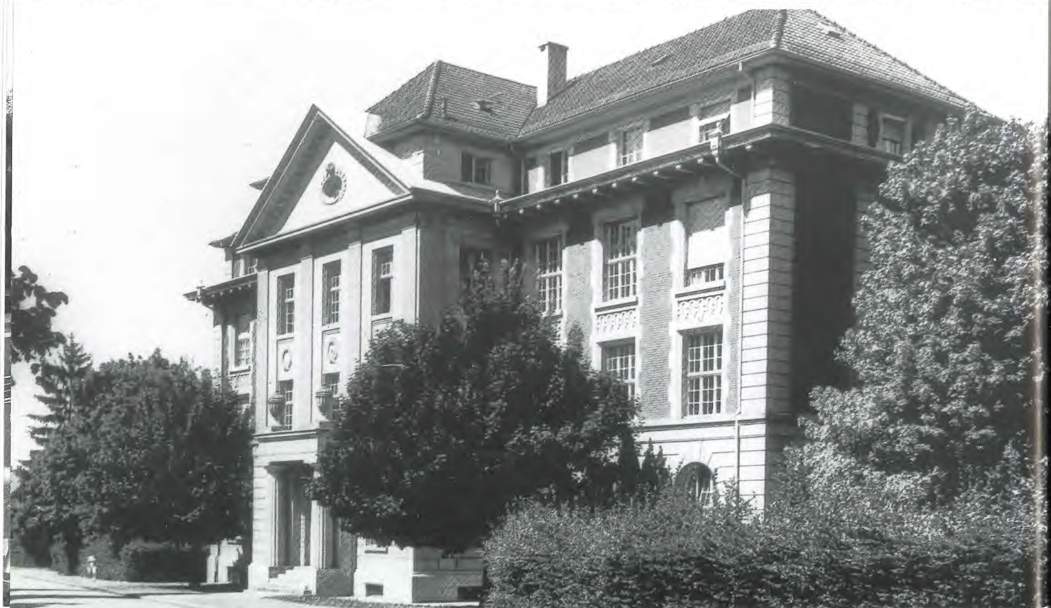
Das Gebäude der Abteilung für Maschinenteknik aus dem Jahre 1912
