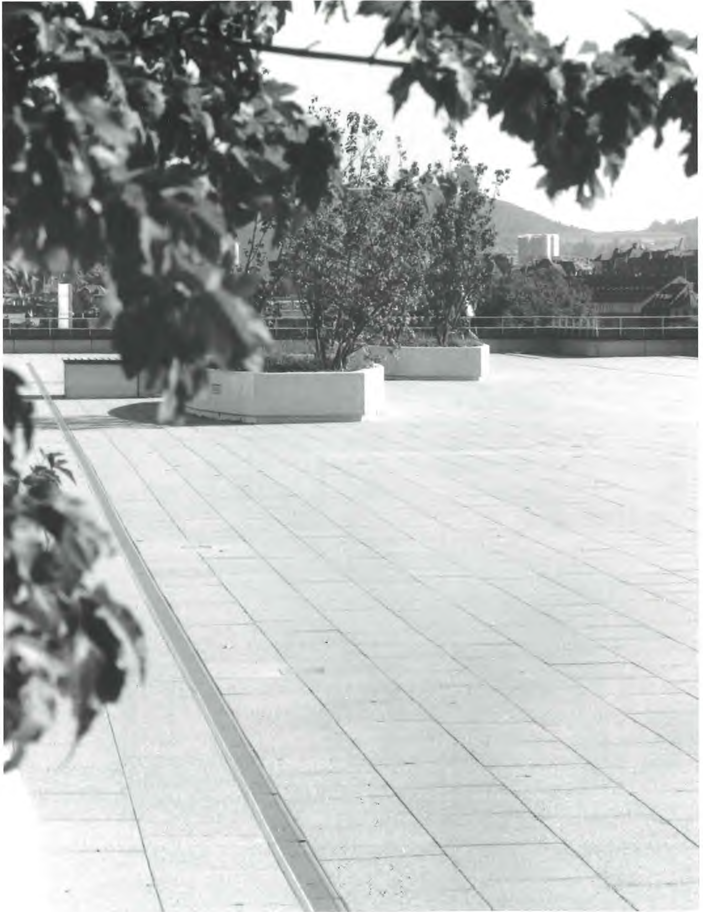
Gehflächen in Betonplatten mit Granitvorsatz, Entwässerungsrinnen in Chromstahl
