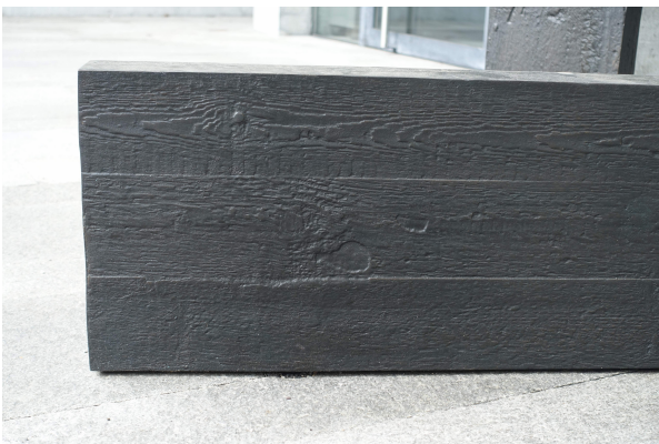
Unterschiedliche Oberflächenstrukturen auf der geschwärzten Bronze
