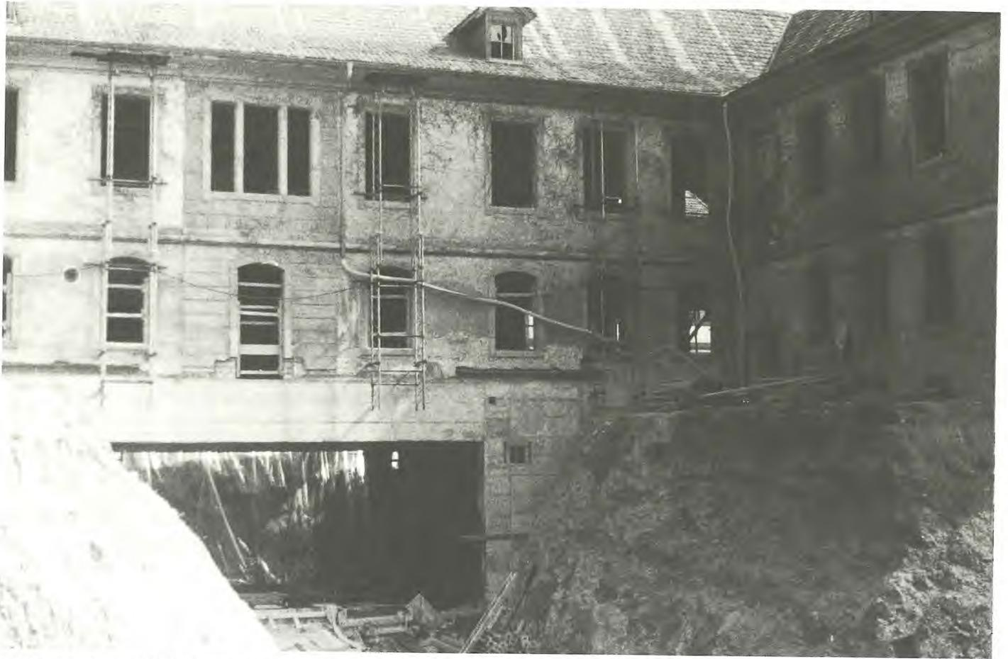
Südfassade, Unterfangung abgeschlossen, der Verbindungsgang kann angeschlossen werden
