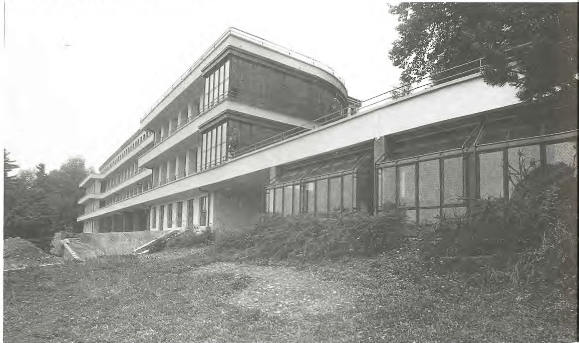
14 Ansicht von Südosten nach Umbau
