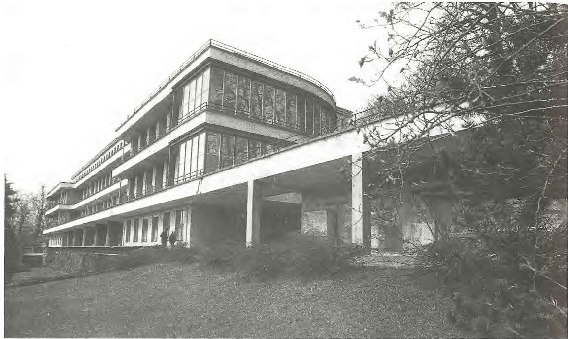
13 Ansicht von Südosten vor Umbau
