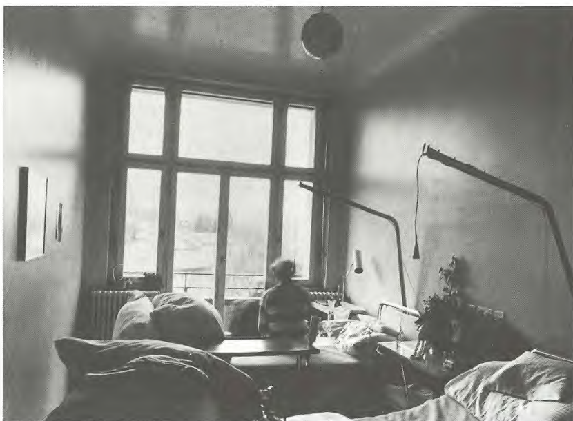
16 Patientenzimmer, vor dem Umbau, 1981
