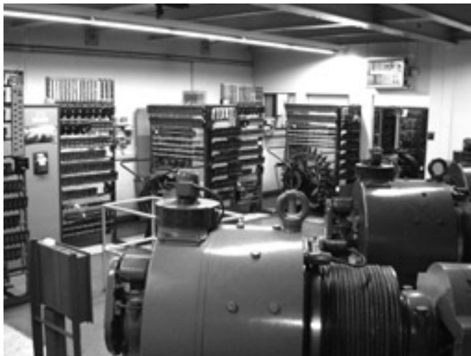
Liftmaschinenraum Nordkopf vor Umbau
