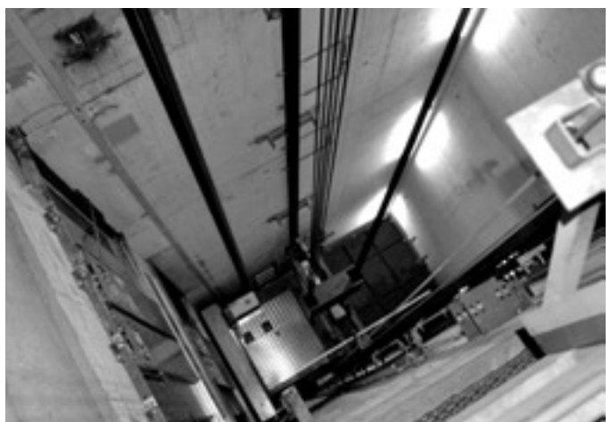
Feuerwehrlift Südkopf, Liftschacht
