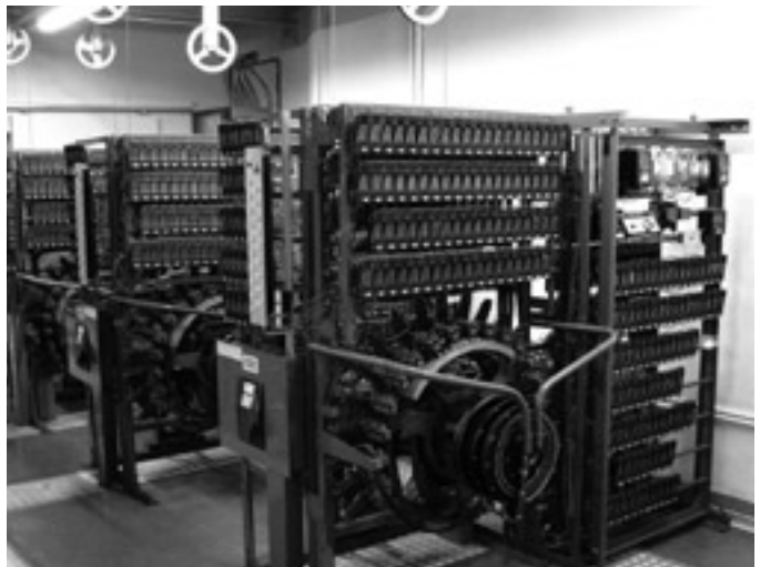
Liftmaschinenraum Nordkopf vor Umbau, alte Relaissteuerung
