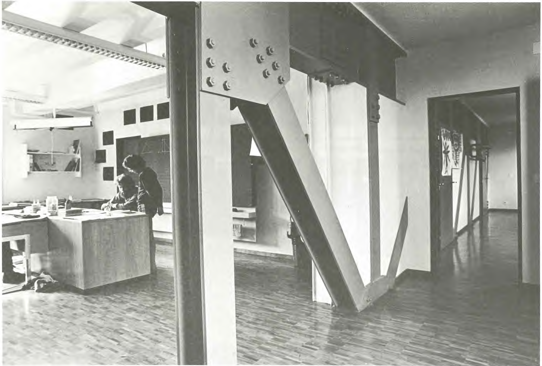
Der Stahlfachträger im 1. OG des Konvikts
