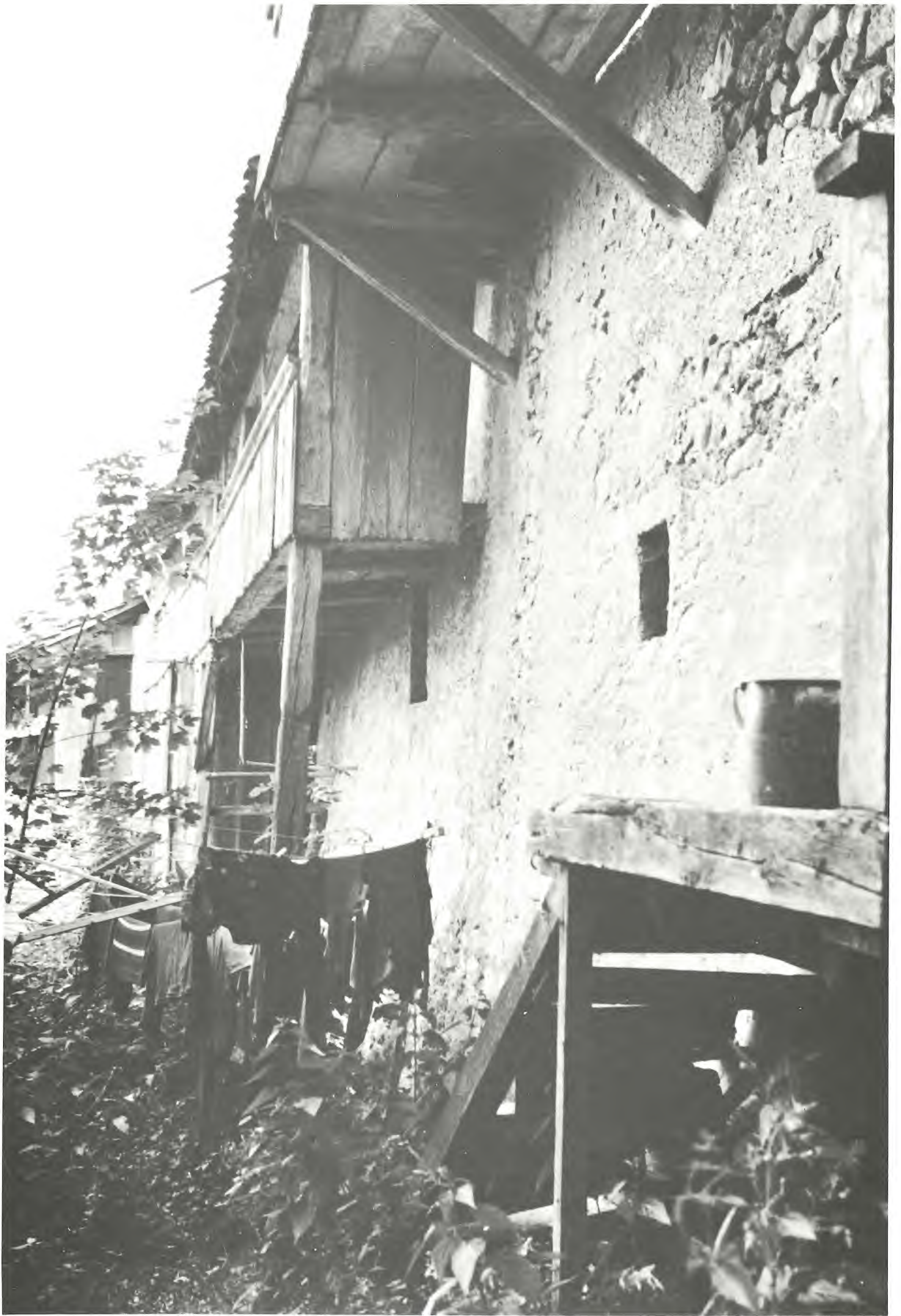
Nordfassade der Altstadthäuser vorher
