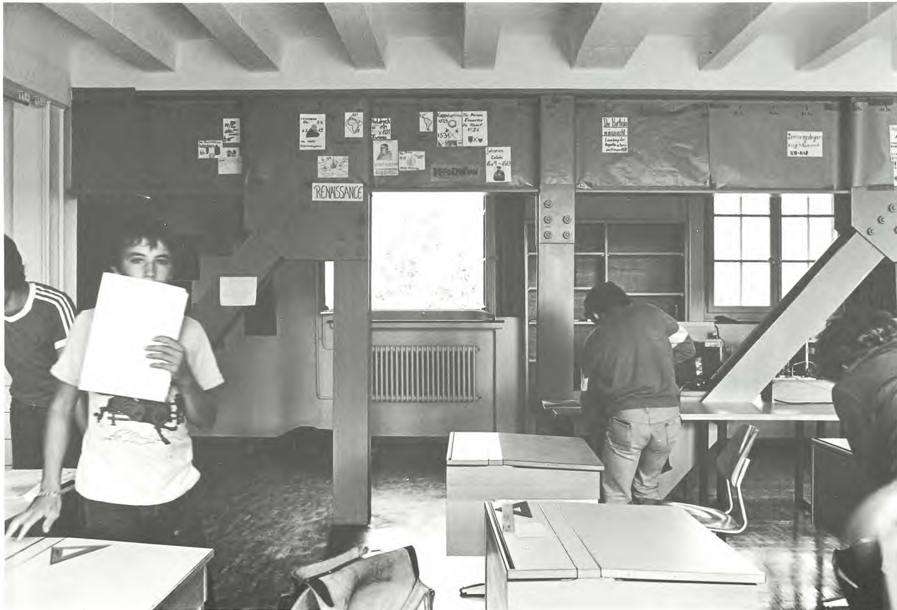
Der Stahlfachträger als Bestandteil des Klassenzimmers
