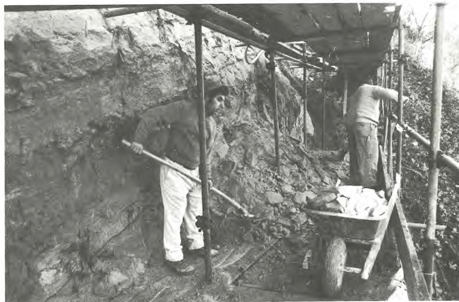
Das Lehrgerüst als Arbeitsbühne
