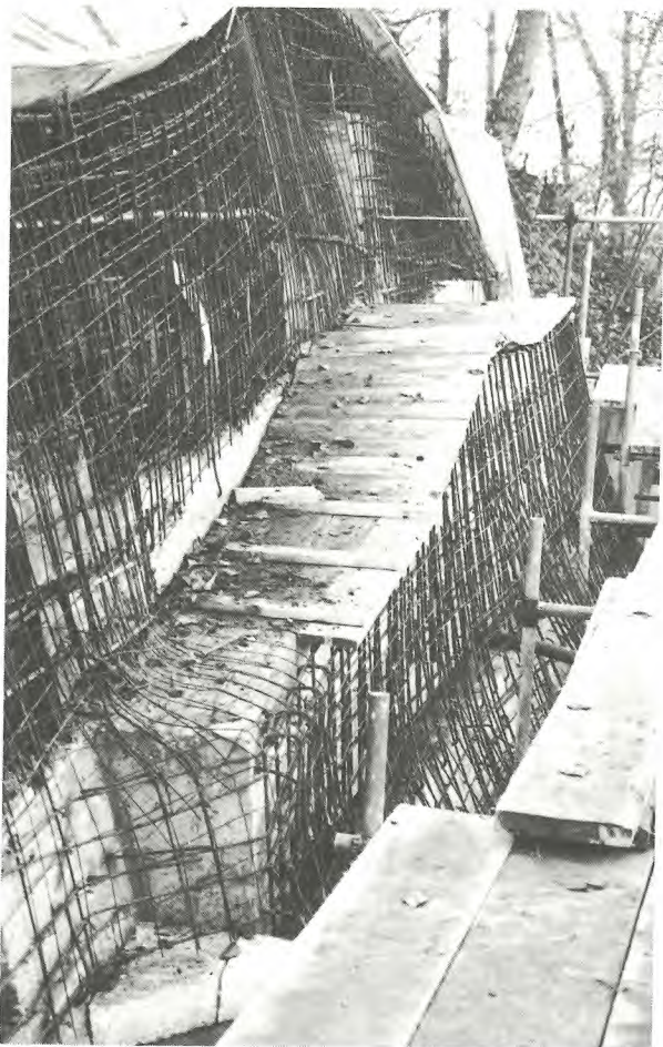
Pflanzentröge vor dem Betonieren
