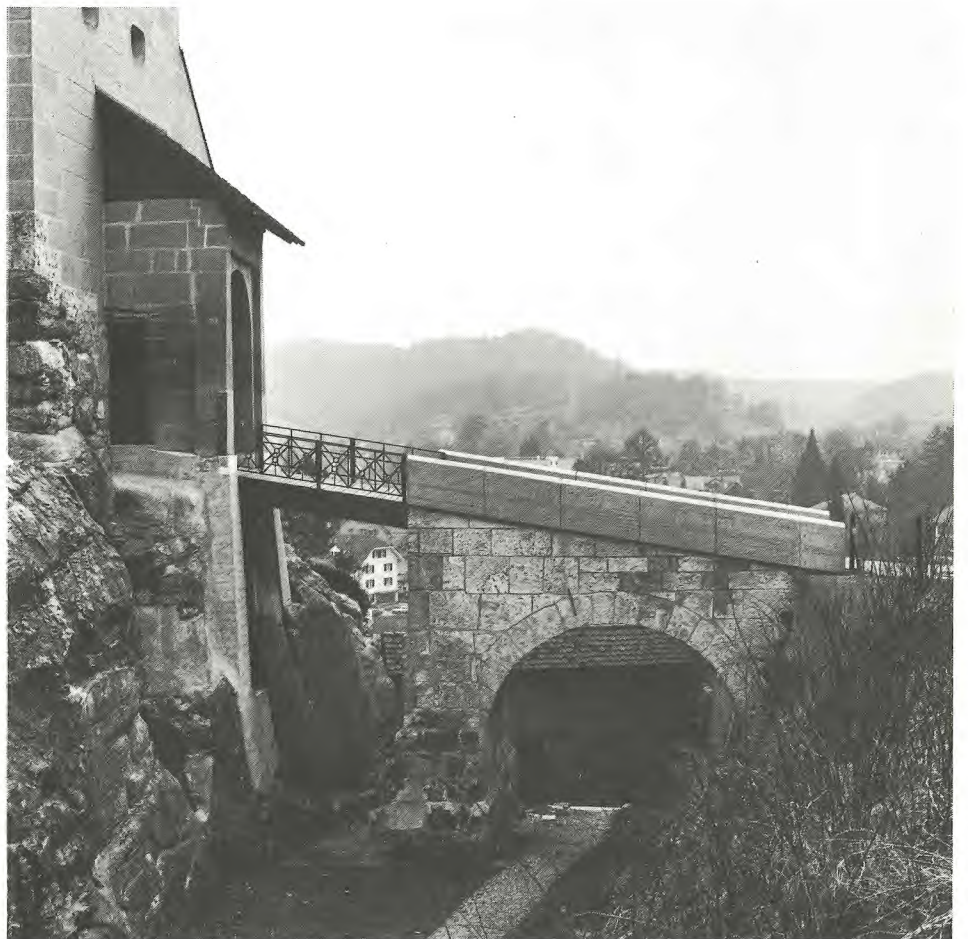
Burggraben, alte Tuff- Bogenbrücke. Ersatz der alten Zugbrücke durch eine Leichtbrücke aus Stahl und Holz
