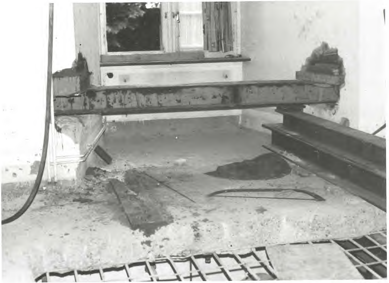
Widerlager für das Pressen der Pfähle unter dem Lift.
