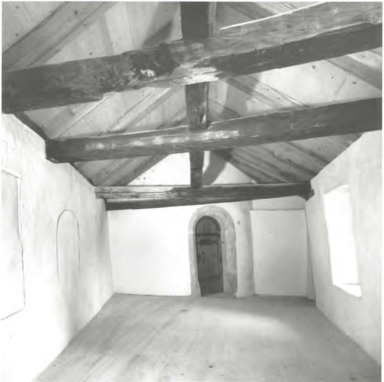
In der "Knechtenwohnung" im 2. Obergeschoss des ehemaligen Gefängnisbaus entstand ein nutzungsneutraler Raum für die Öffentlichkeit.
