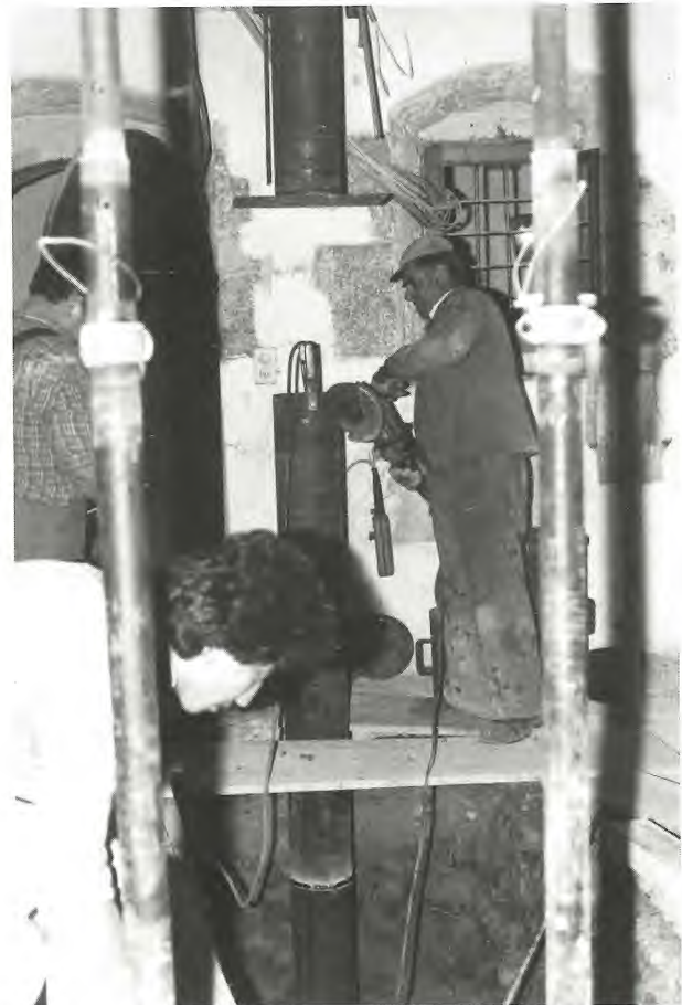
Widerlager für das Pressen der Pfähle unter dem Lift.
