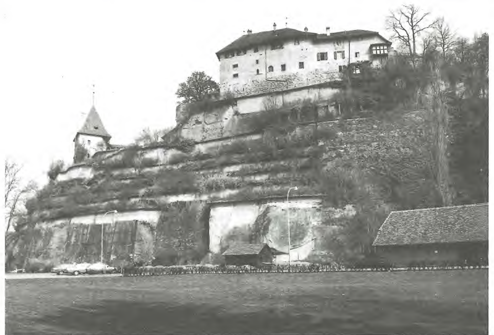
Schloss und Felsen von Südwesten, vor der Sanierung 1910/11. Schlossfelsen nach der Sanierung, Zustand November 1925. Zustand im April 1979, üppiger Bewuchs auf den Terrassen.
