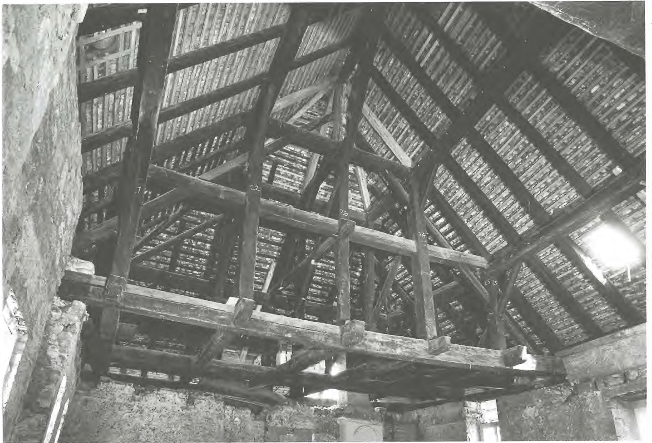
Blick in die Osthälfte des nur auf den Aussenmauern aufruhenden Walmdachstuhls über dem Palas, aufgerichtet im späten 14. Jahrhundert. Zustand Mai 1987.
