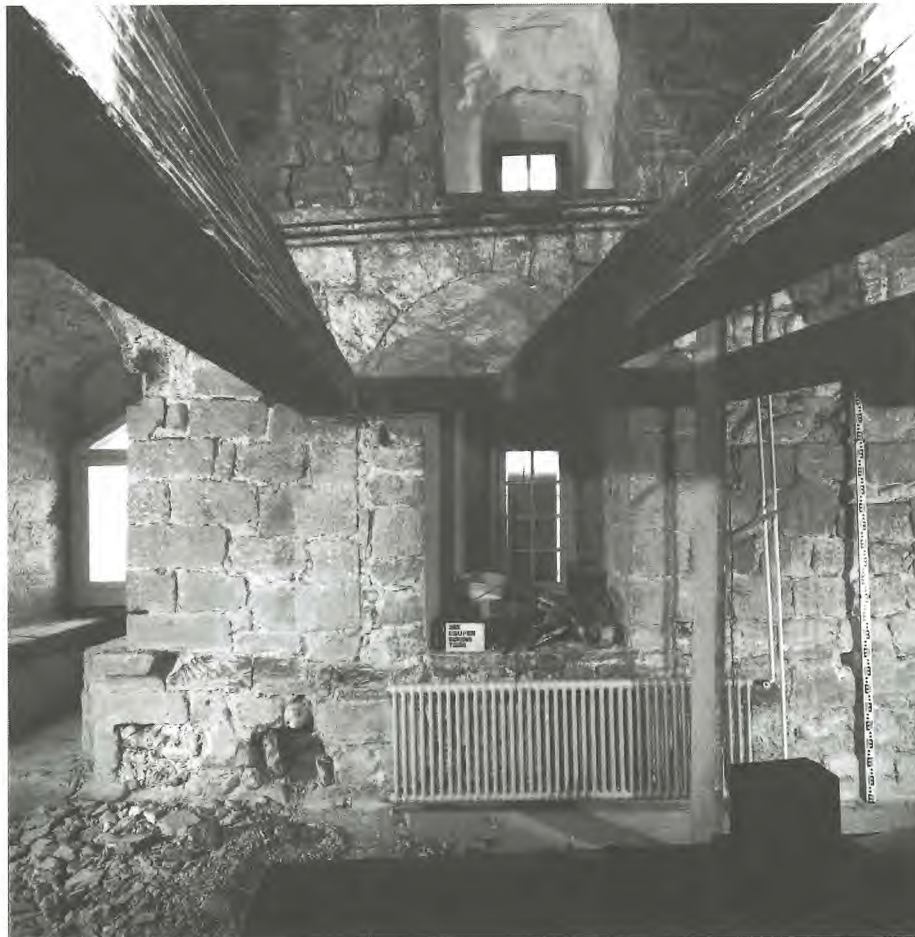
Der Rittersaal gegen Westen gesehen. Oben: Kurz nach Abbruchbeginn der zweigeschossigen Gefängnis- und Kornhauseinbauten. Unten: Vermauerte Sitznische der Zeit um 1300 mit Zwischenboden von 1704. Zustand Juli 1986. Rechts: Der restaurierte Saal mit den drei frühgotischen Fenster­nischen und der um 1453 erneuerten Decke.
