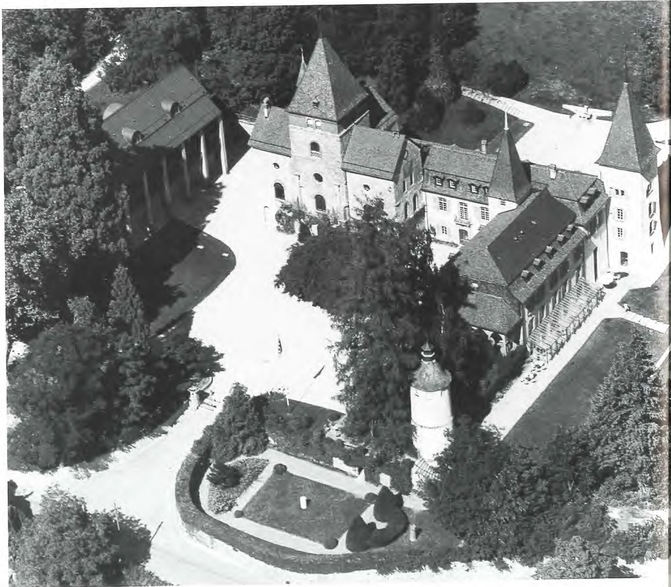
Gesamtanlage von Südwest, 1990
