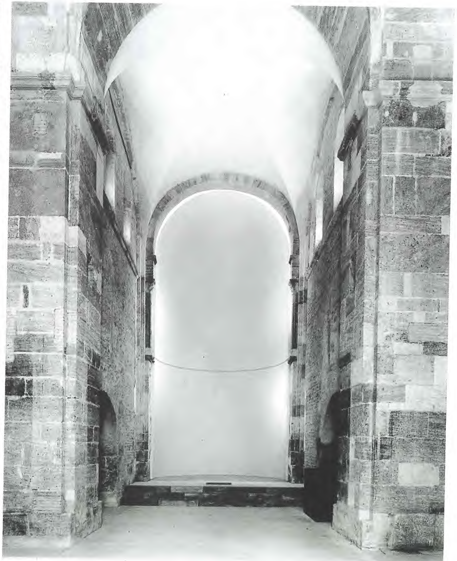
Blick auf die Chorzone von Südosten vor und nach dem Umbau.
