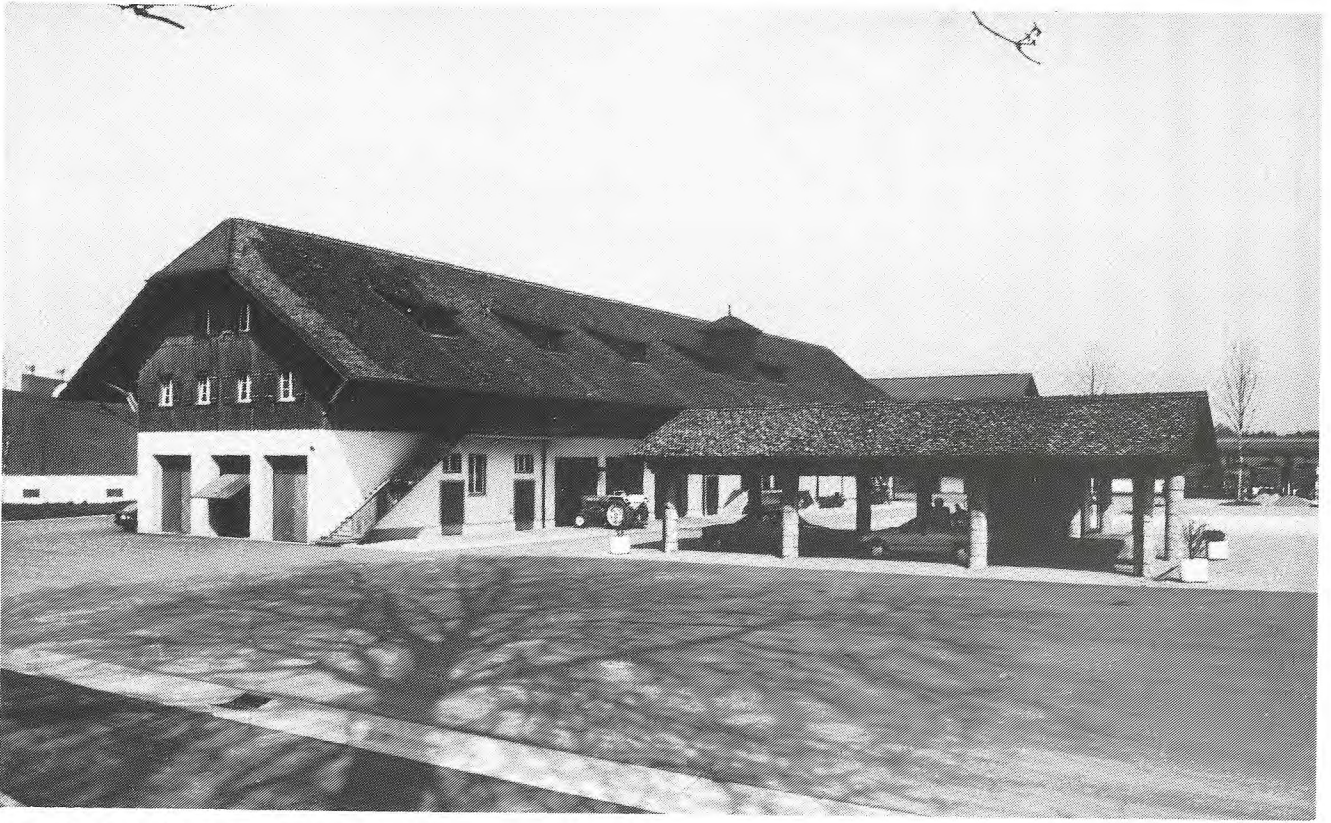
Umbau und Renovation Brunnenhaus und Gebäude 38
