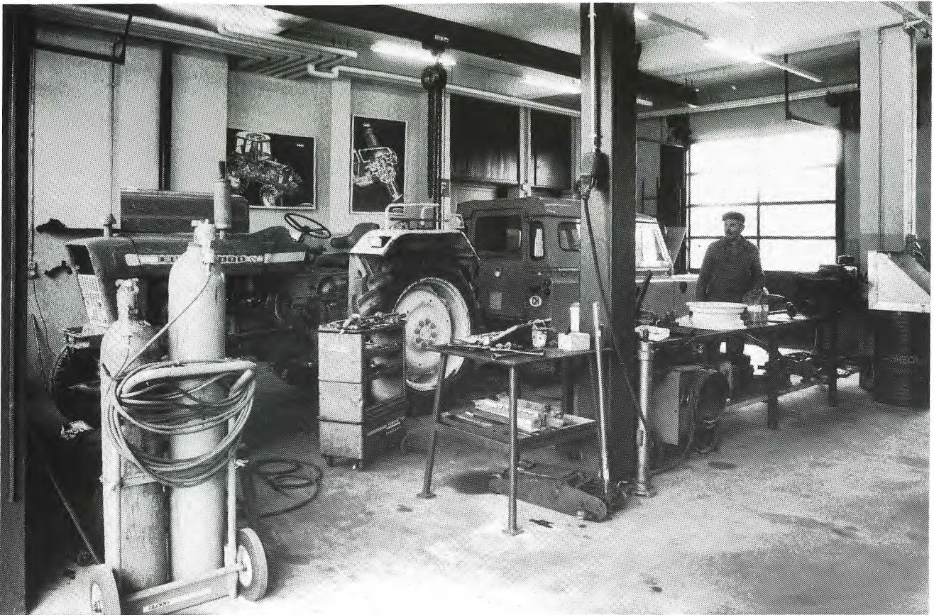
Umbau Gebäude 38, Traktorenwerkstatt
