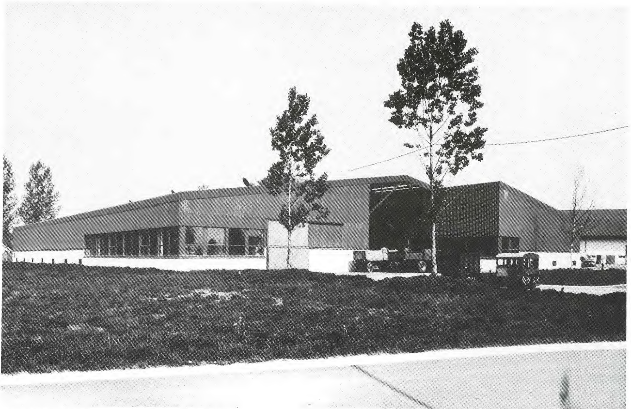
Lagerhallen, Ansicht Süd-Ost
