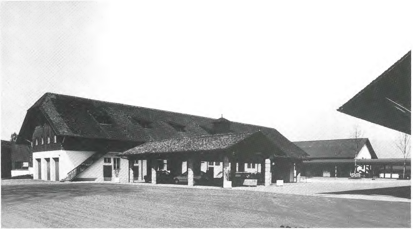
Brunnenhaus, dahinter Oekonomiegebäude (Gebäude 38)
