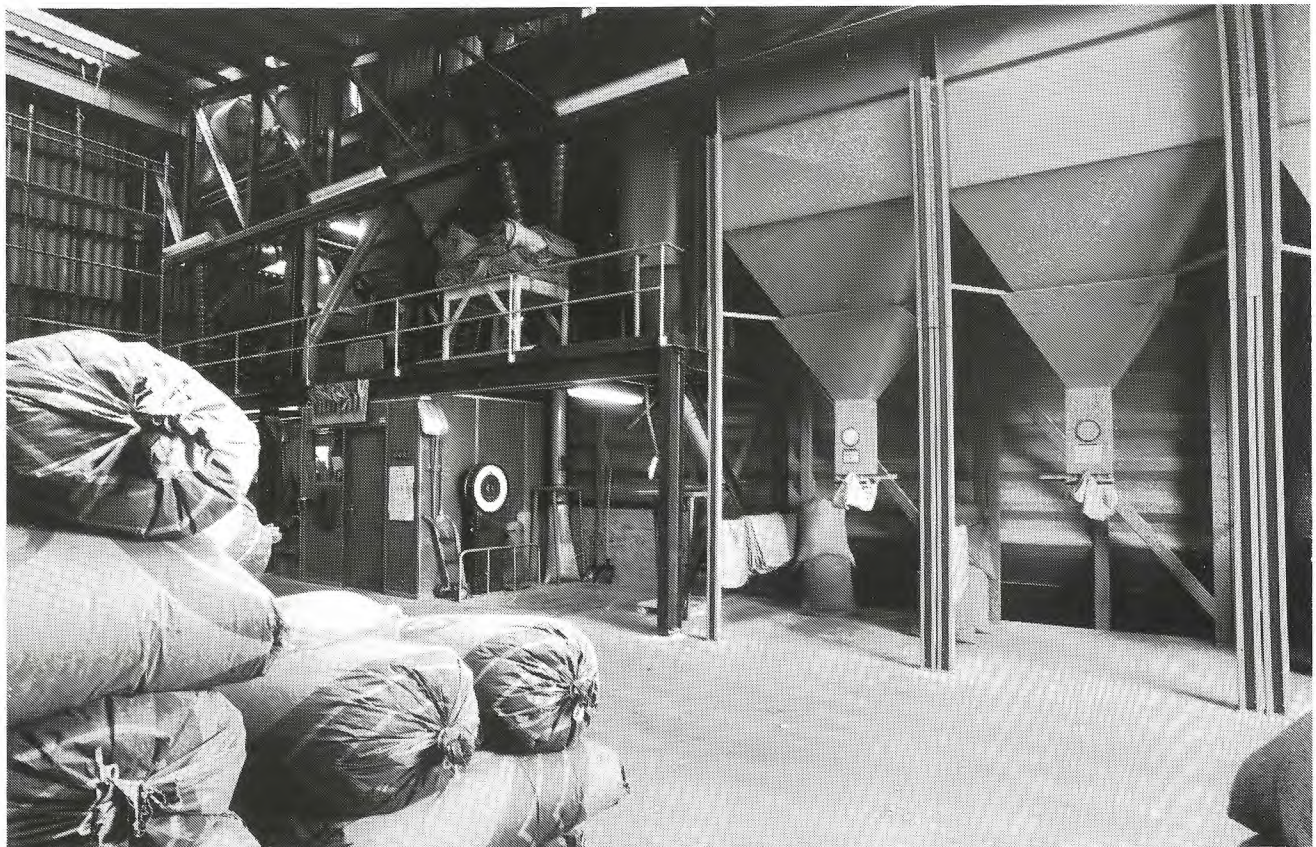
Mühle, mit Futtersilos
