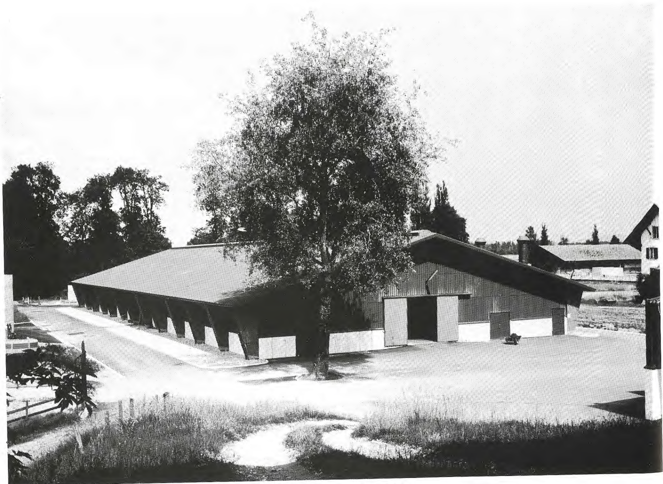
Der Milchviehstall von der (nicht mehr bestehenden) Rampe des Gebäudes 201 aus
