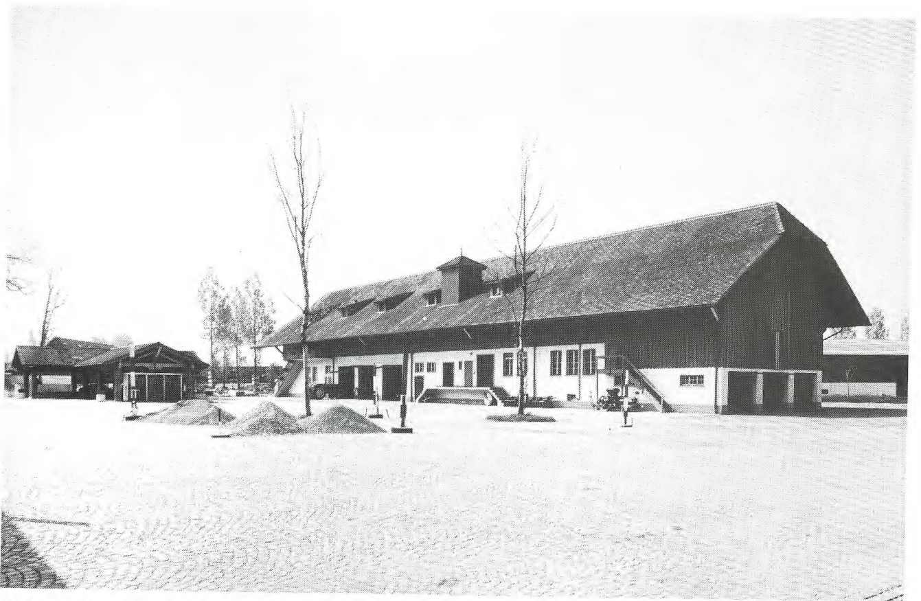
Hof mit Brunnenhaus und Gebäude 38
