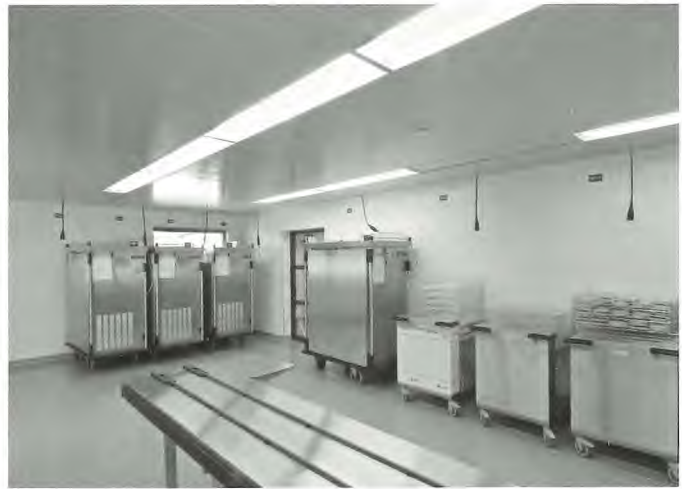
Portionierung Förderband und Speisewagen
