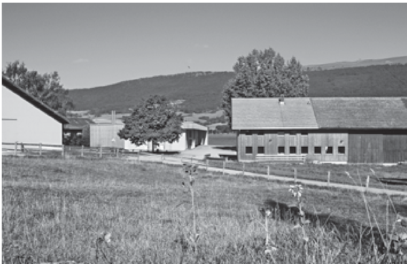
La Praye Garage, agromécanique, sapeurs-pompiers, bâtiment d'exploitation agricole
