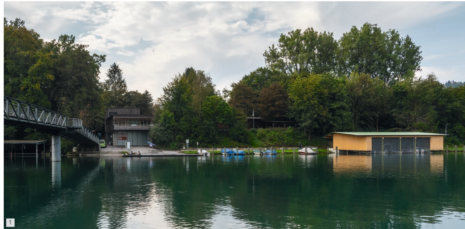
1 Das Ensemble der Holzbauten beim Stägmattsteg: das Gebäude des Rowing Clubs, des Fischervereins und das neue Bootshaus KAPO Bern.
