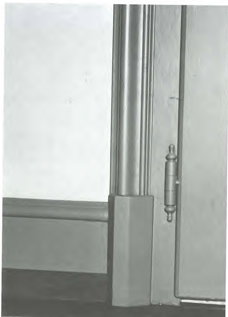
Détail du raccord porte – soubassement.
