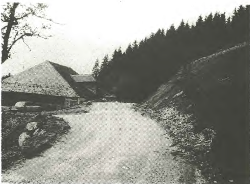
Die neue Strasse auf der Nordseite im Bau (vergleiche Quer- profil nächste Seite)
