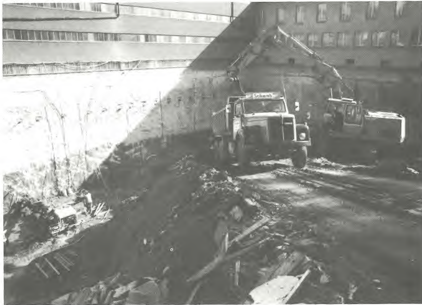
Während der Bauausführung
