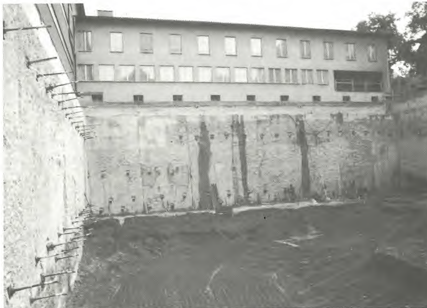
Die fertige Baugrube mit Schlitzwand mit einer Tiefe von ca. 13,5 m
