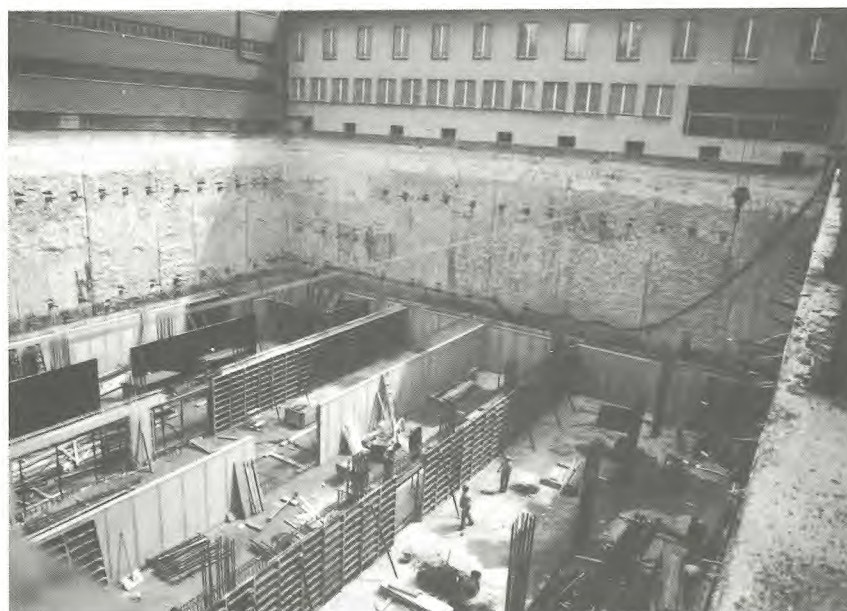
Baubeginn mit dem 4. Untergeschoss des Archivs
