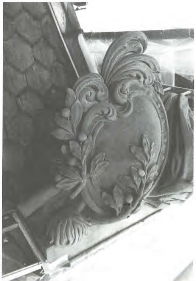
Die Fahngruppen beidseitig der Hauptlukarne zeigten Risse, insbesondere in den Tuchfalten. Diese wurden z.T. ausinjeziert und mit Mörtel verschlossen. Eine Stangenspitze musste ersetzt werden.
