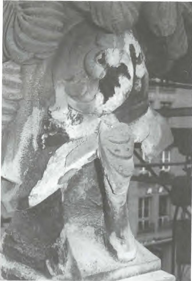
Mittels Verklebungen, Verankerungen durch Chromstahlbügel wurde in der Folge die Grundlage geschaffen, die fehlenden Zierteile sowie das Visier nachzumodellieren. Einzig in Hartstein zugefügt werden musste der rechte Ohrschutzlappen.
