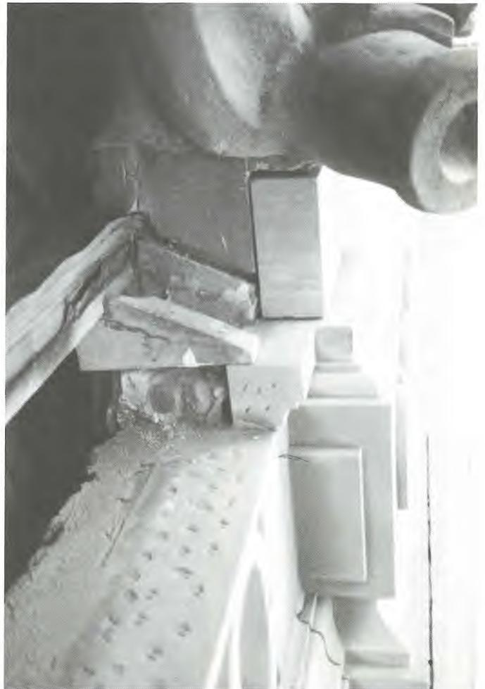
Die Säulen mit Basis und Kapitell wurden ersetzt. Sie wurden aus 1 Stück (nicht lagerrichtig) gedreht, wobei der Schaftdurchmesser um die bei früheren Renovationen verloren gegangenen Zentimeter erhöht wurde. Die Basen wurden mit ca. 8 - 10 Liter Steinfestiger getränkt. Eine erste Prüfung der Wasseraufnahmefähigkeit ergab gegenüber den unbehandelten Flächen ca. Faktor 10.
