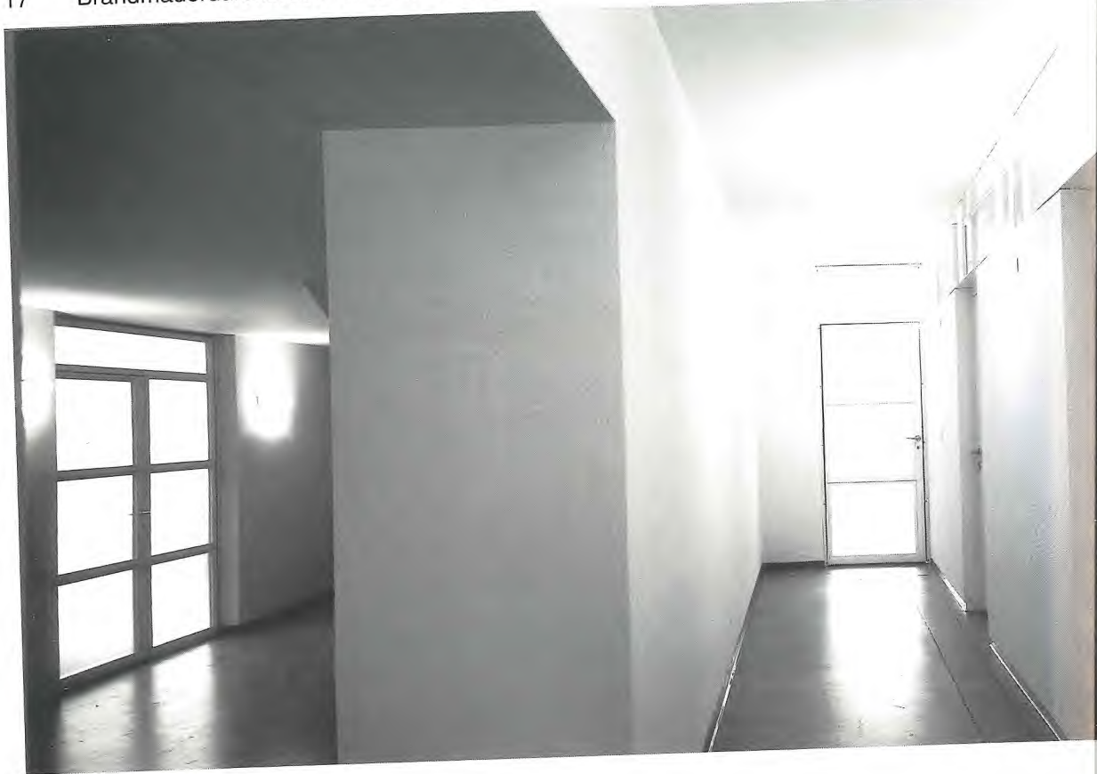
17 Brandmauerdurchbruch Nr. 1 und Nr. 63
