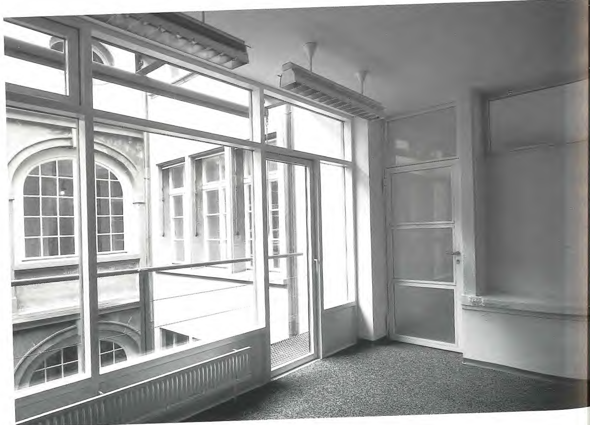
18 Neue Hofbüros (2. OG)
