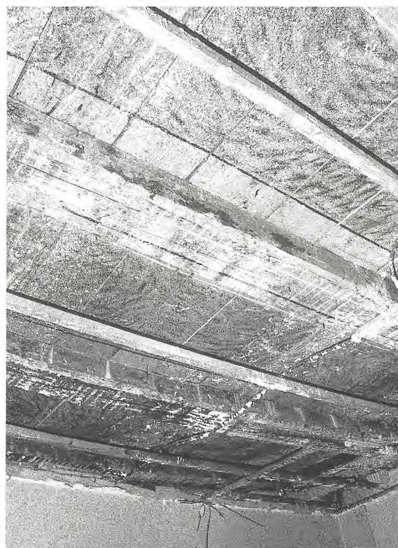
7b Barocke Balkendecken
