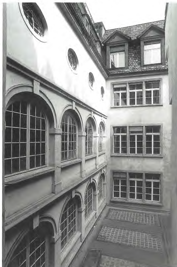
5 Hofüberbauung vor Umbau
