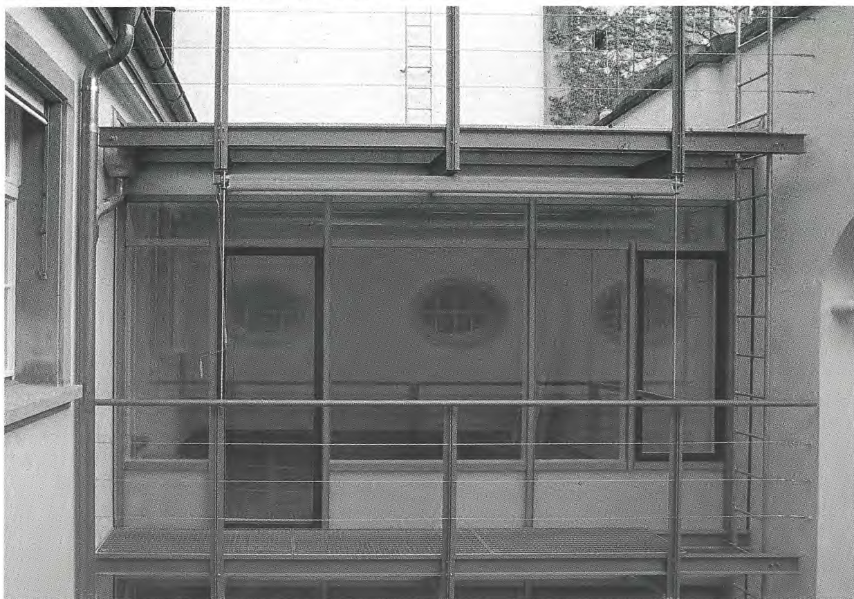
13 Blick von der Hofgalerie auf den neuen Hofanbau ...
