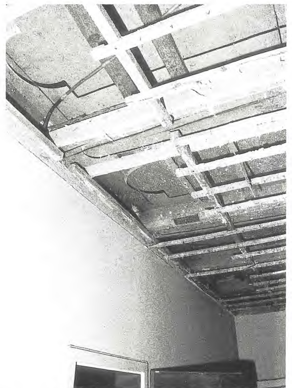
7a Barocke Balkendecken
