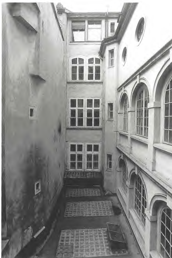
6 Hofüberbauung mit WC-Turm
