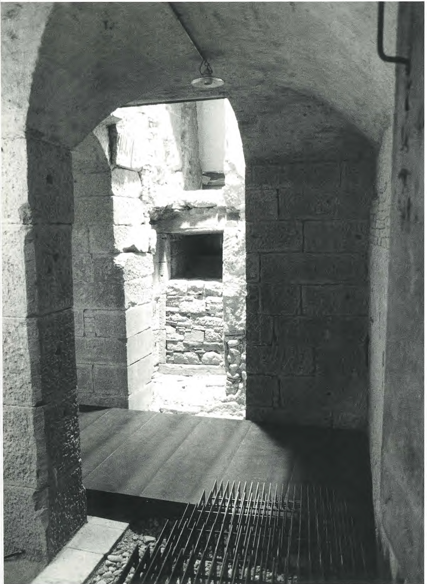
Das Zisternengeschoss des Lenbrunnens. Blick über die neue Stahlterrappe und -bühne an die Nordwand. Im gefrästeten Schlitz wird die mittelalterliche Nordmauer sichtbar.
