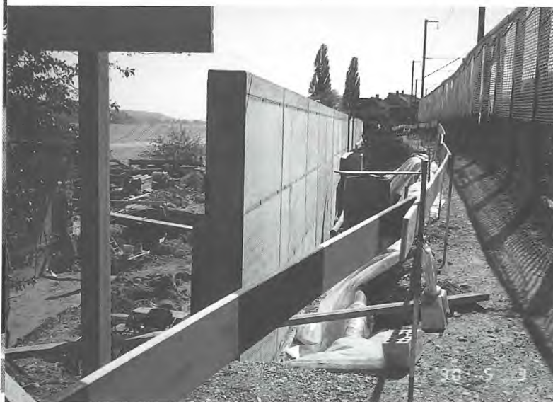
Stützmauer im Rohbau
