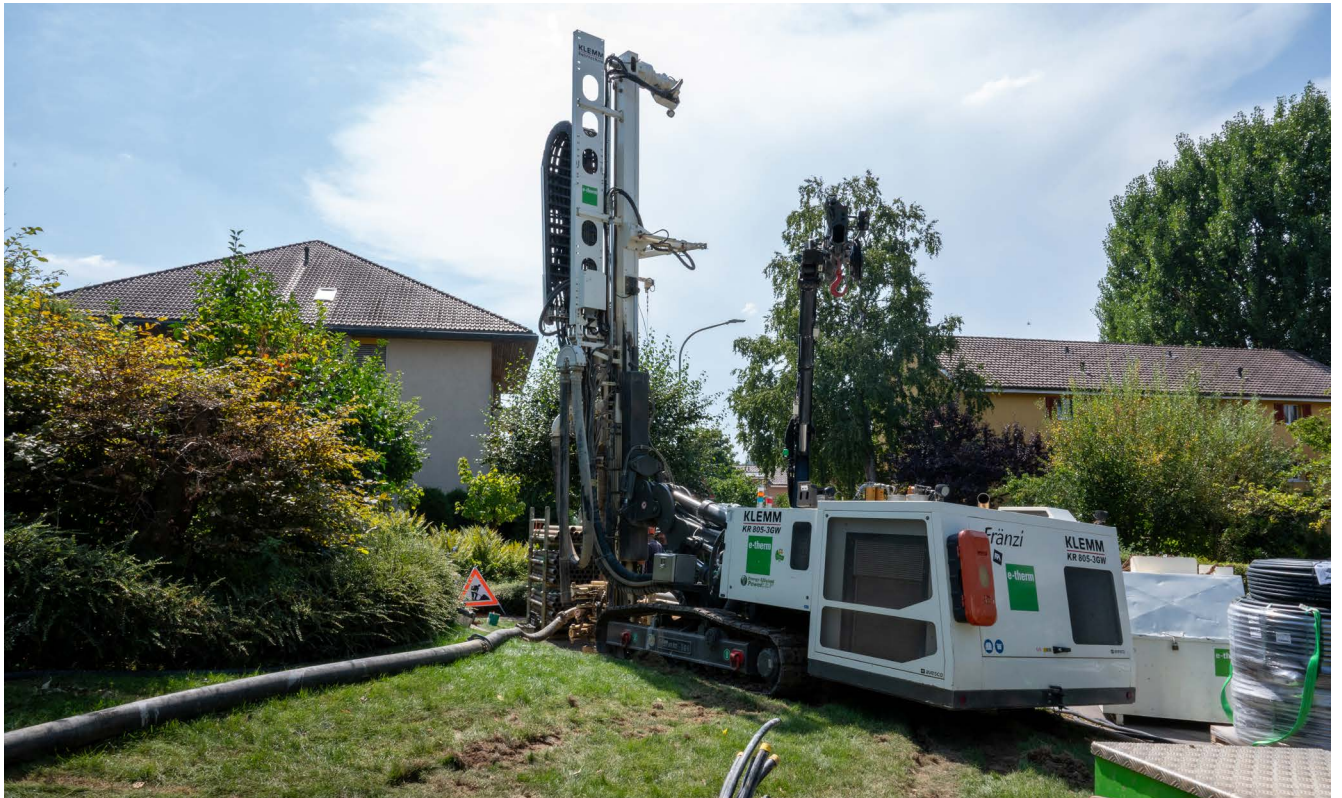
Eine solche Maschine kommt beim Bau des Erdsondenfeldes zum Einsatz.
