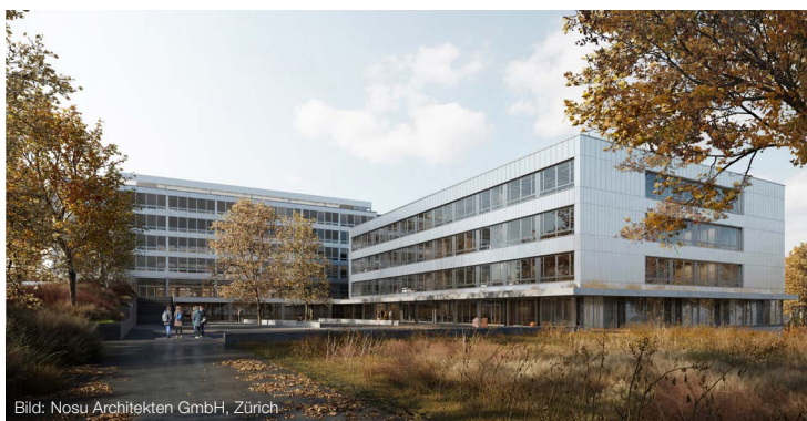
Blick auf den Erweiterungsneubau (Vordergrund) und das Hauptgebäude aus Sicht Bremgartenstrasse.
