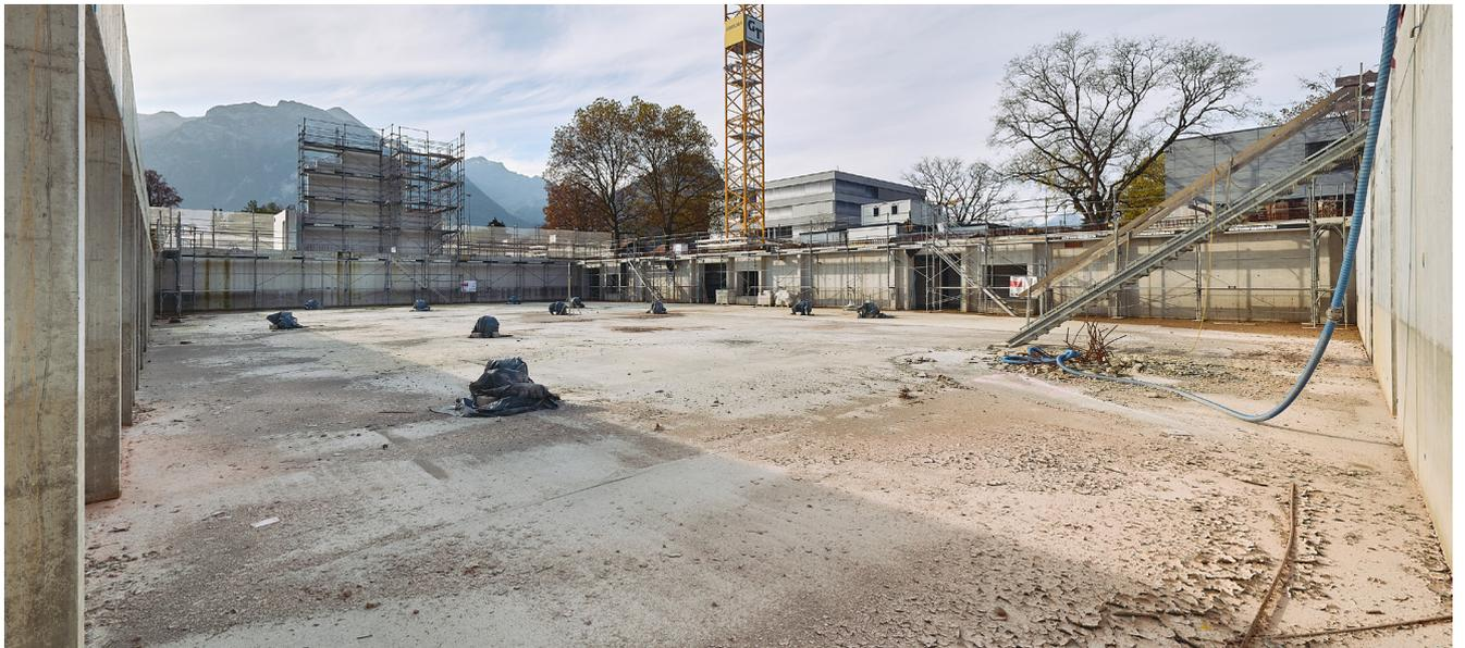
Unterhalb dieser Bodenplatten ist die Verankerung gebrochen. Der Rohbau muss abgebrochen und neu gebaut werden.
