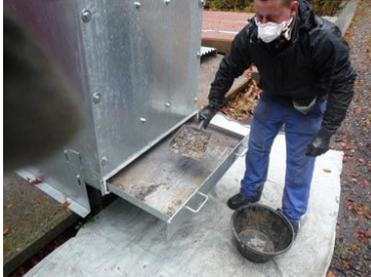
Eine korrekte Wartung von künstlichen Kugelfangsystemen (KFS) ist wichtig für die Funktionstüchtigkeit der Systeme und den Schutz der menschlichen Gesundheit. Die Betreiber einer Schiessanlage sind für eine regelmässige und korrekte Wartung des KFS verantwortlich. Bei unsachgemässen Unterhaltsarbeiten verteilen sich die gesundheitsgefährdenden blei- und antimonhaltigen Stäube in die Umwelt. Diese Stäube können über die
