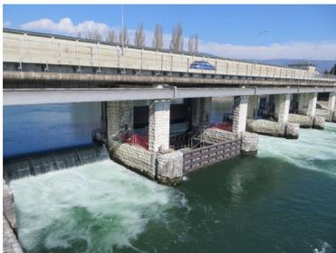
Das von 1936 bis 1939 gebaute Regulierwehr Port ist eine Schlüsselstelle der Juragewässerkorrektion. Die Anlage umfasst neben dem Regulierwehr eine Schiffschleuse, eine Strassenbrücke und seit 1995 ein Wasserkraftwerk. Mit dem Regulierwehr werden die Wasserstände der drei Jurarandseen und der Abfluss der Aare aus dem Bielersee reguliert.
