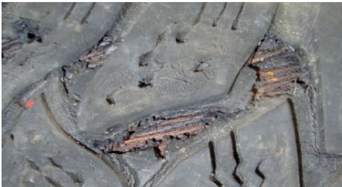
Stahlgürtel und Abdecklage sichtbar.
