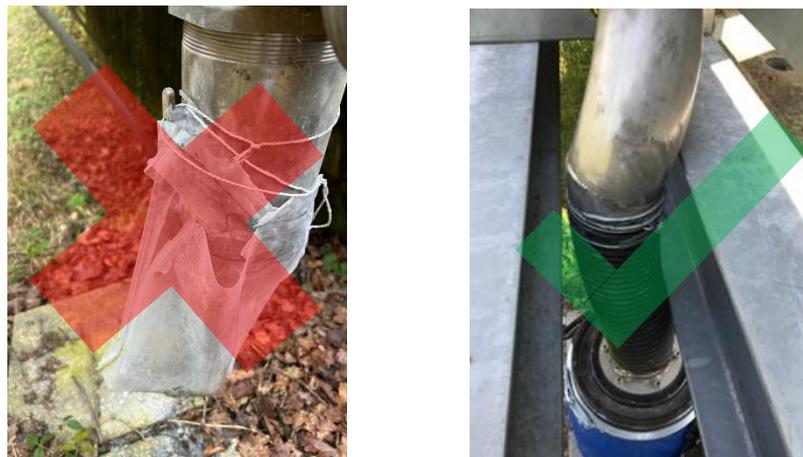
Abbildung 1: Sammelgebinde für das Berin-System (links unzulässiger Plastiksack, rechts zulässiges festes Gebinde)
