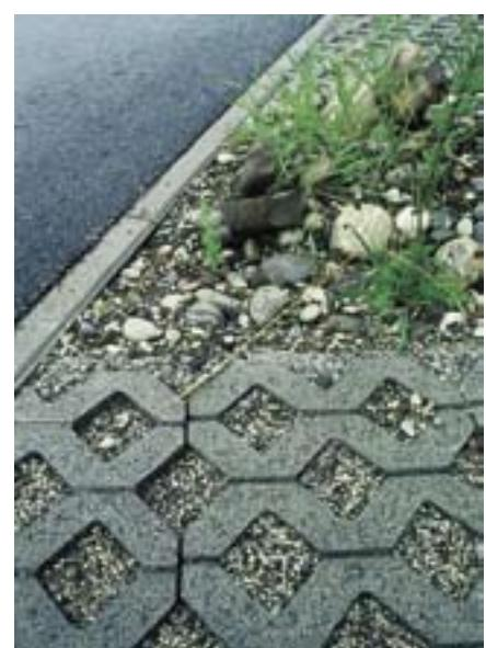
Freier, seitlicher Abfluss dank strassenbündigen Randabschlüssen.
