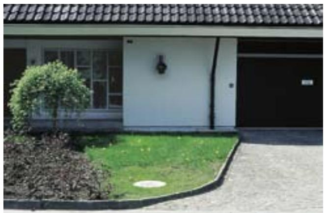
Das Dachwasser wird zum Schacht geleitet, wo es aufsteigen und breitflächig in der Rasenfläche versickern kann.
