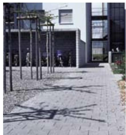
Die internen Verbindungswege kommen ohne Entwässerungseinrichtungen aus. Das Regenwasser kann seitlich abfließen und direkt versickern.
