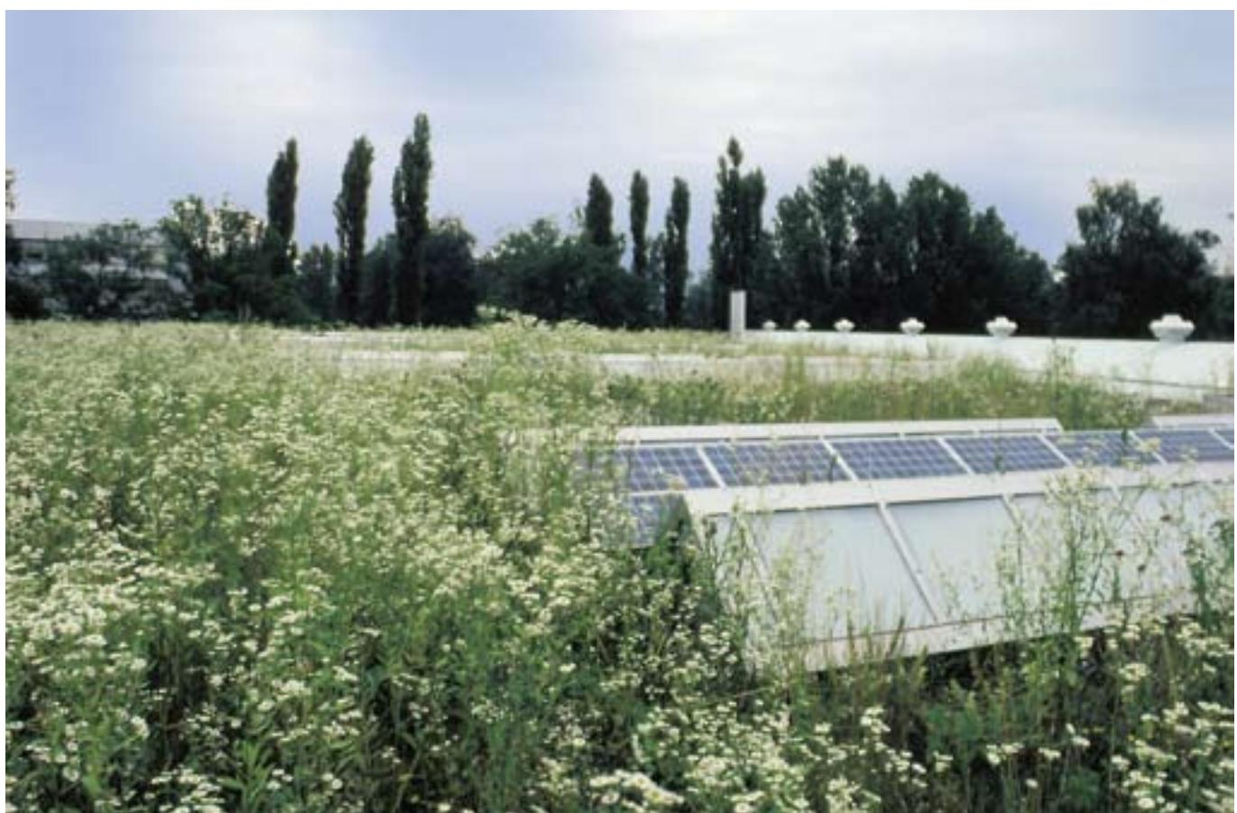
Gründächer sorgen für einen verzögerten und verringerten Wasserabfluss. Dies ermöglicht dem Wasser die Versickerung auch in weniger idealen Böden.
