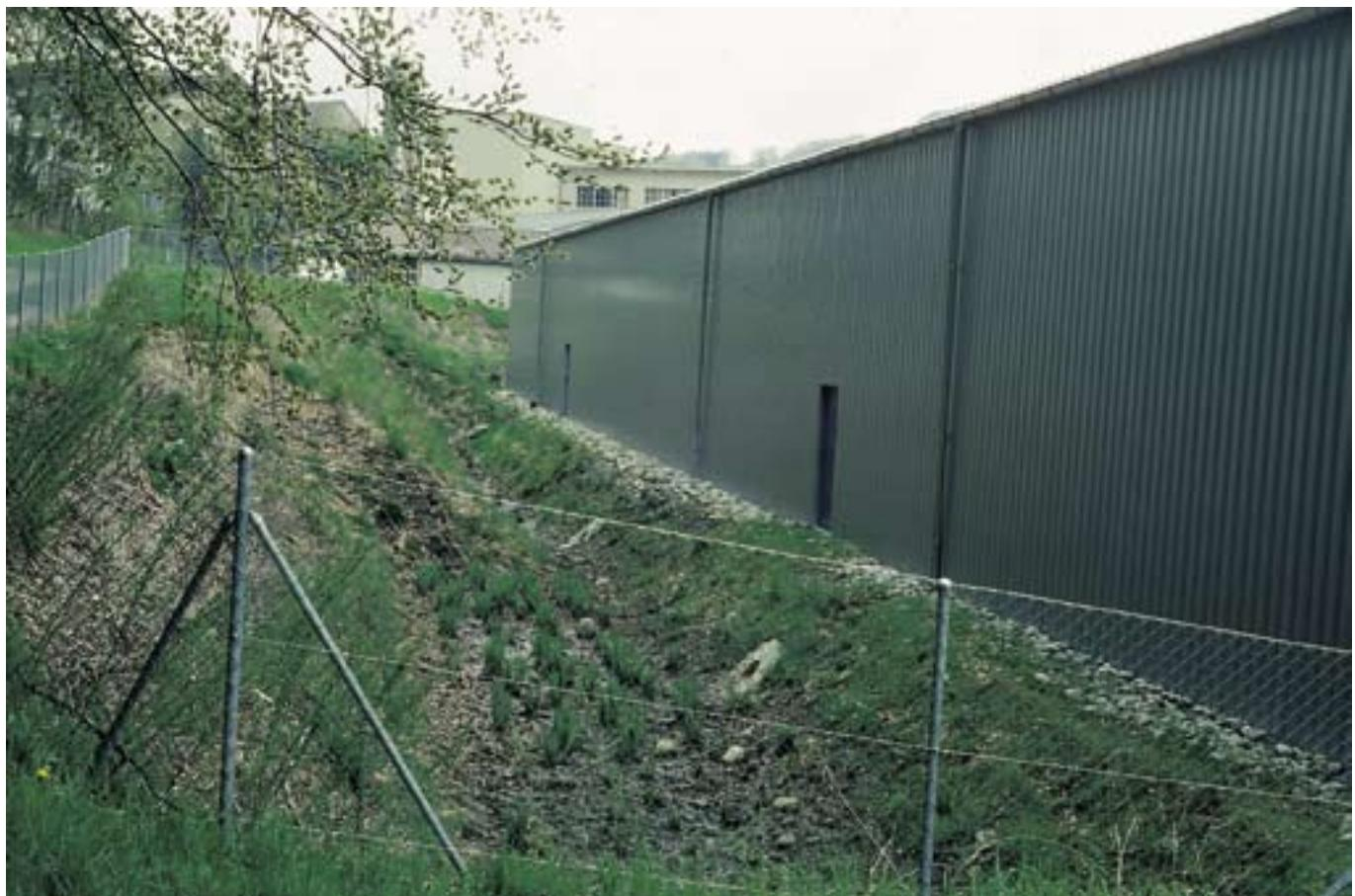
Das Dachwasser fliesst direkt in das Versickerungsbecken. Die hinter dem Gebäude liegende Parzellenfläche wird so optimal genutzt.
