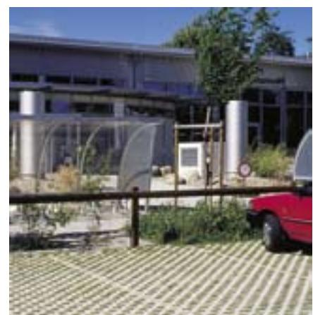
Rasengittersteine ermöglichen das Versickern an Ort.
