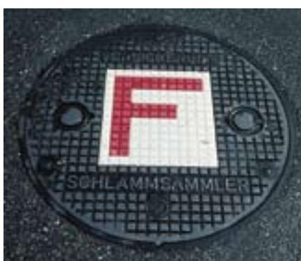
Kontrollschacht für die Feuerwehr. Die Markierung ist sehr wichtig, weil die Leitung zum Versickerungsbecken im Brandfall abgesperrt werden muss.
