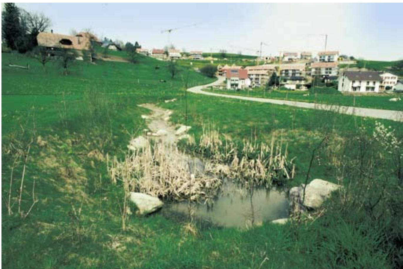
Der undurchlässige Boden und die Hanglage verunmöglichen es, das Regenwasser der Überbauung direkt an Ort versickern zu lassen. Es wird daher in einen Retentionsweiher in der Talebene geleitet und fliesst von dort gedrosselt in einen Bach. Ein Teil des weniger verschmutzten Regenwassers, das nach dem ersten Spülstoss anfällt, wird in einem Speicher gesammelt und für die Toilettenspülungen verwendet.
