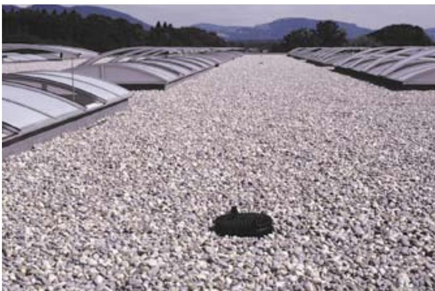
Die vorliegende Lösung kombiniert eine Dachretention mit Abflussdrosselung und anschliessender Versickerung. Ein verhältnismässig kleines Versickerungsbecken kann das gesamte Niederschlagswasser auf dem Gelände aufnehmen.
