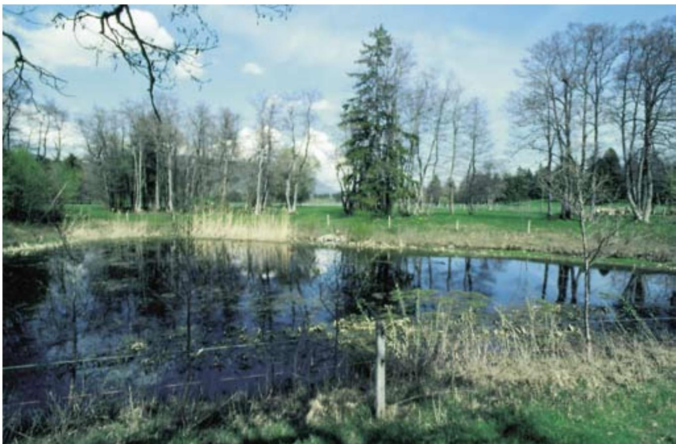
In Nods wurde eine alte Betonrohrleitung mittels Relining saniert. Am oberen Ende erstellte man ein Retentionsbecken, um die Abflusskapazität der Leitung nicht zu überschreiten. Dieses fasst 6000 m<sup>3</sup> Wasser und ist als natürlicher Weiher gestaltet. Nach der Fertigstellung stellte man diesen unter Naturschutz. Der in den 20er Jahren eindolte Zufluss konnte bei dieser Gelegenheit auf einer Länge von 800 m renaturiert werden.
