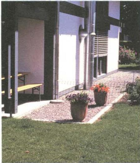
Das Regenwasser dieses Wohnhauses versickert vollständig innerhalb der Parzelle, und dies trotz beschränkter Platzverhältnisse. Unter der Rasenfläche befindet sich ein Versickerungsstrang für das Dachwasser.
