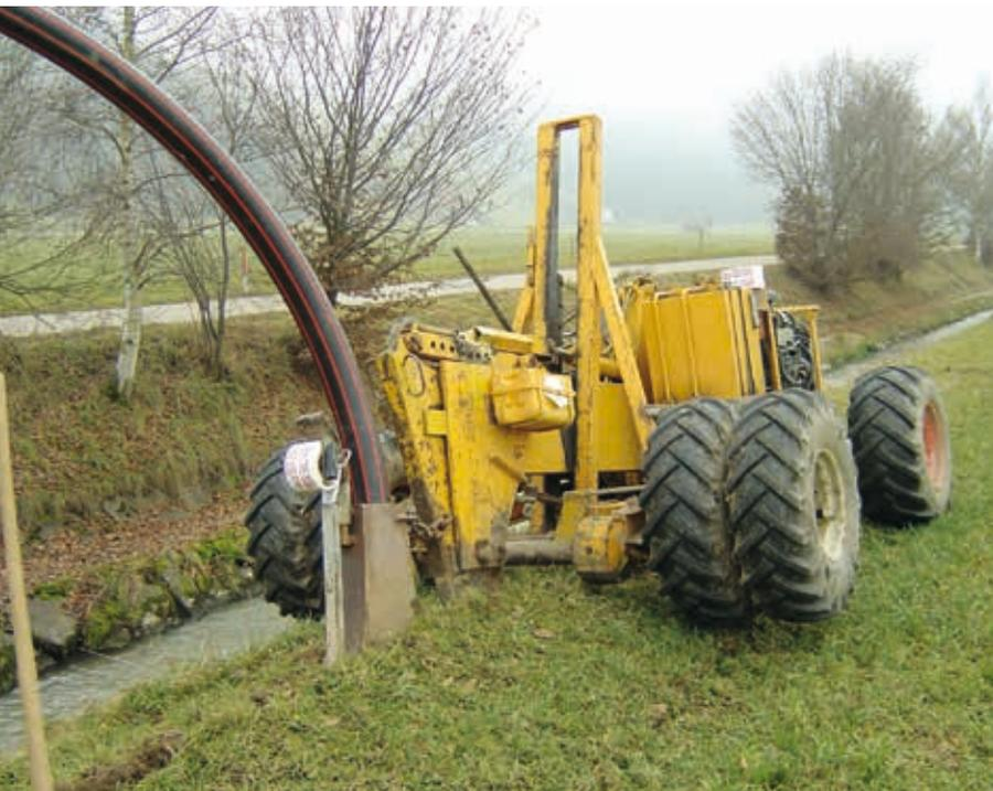
Abb. 1: Eine häufige GEP-Massnahme im ländlichen Raum ist der Kanalisationsanschluss von Liegenschaften, hier realisiert durch Einpfügen einer Leitung
