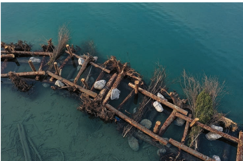
Holzriffe im Brienzersee dienen u. a. als Fischunterstand. Diese Aufnahme erfolgte kurz nach Fertigstellung bei sehr niedrigem Wasserstand. Koordinaten: 2'646'390, 1'176'640
