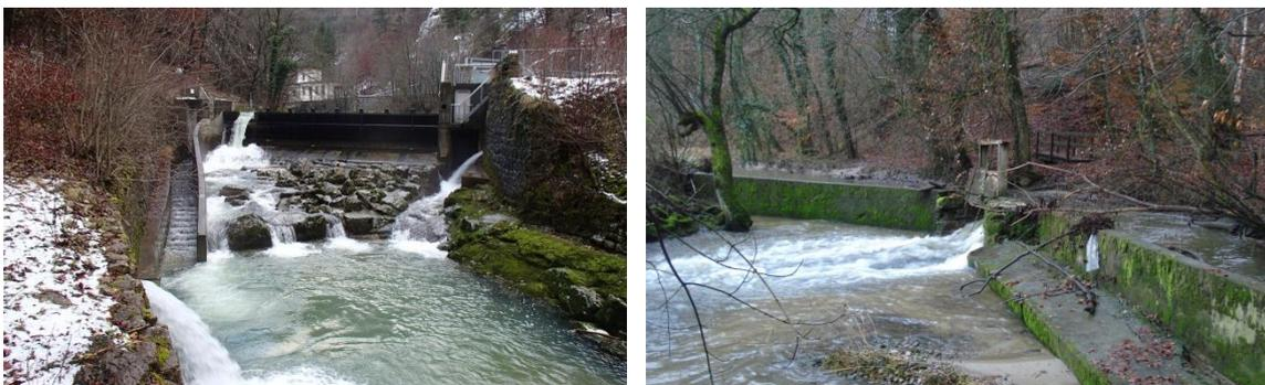
Abb. 10 Besichtigte Anlagen: Fassung für die KW Frinvillier und Evillard an der Schüss mit Borstenfischpass (links) und beschädigtes Wehr mit Fassung an der Bibere bei Ferenbalm (rechts).
