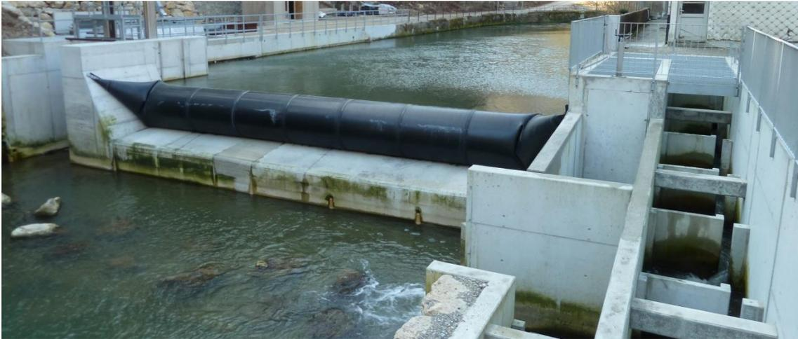
**Abb. 11** Fischaufstieg des Kraftwerks Rondchâtel an der Schüss. Der Fischpass wurde nach dem neuesten Stand der Technik gebaut und im 2014 in Betrieb genommen.
