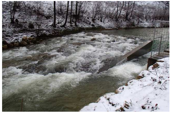
Blockrampe, La Birse bei Moutier (Zentralen Nr. 53021)
