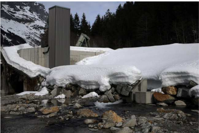
Fischlift, Gadmerwasser bei Fuhren (Zentralen Nr. 16101)
