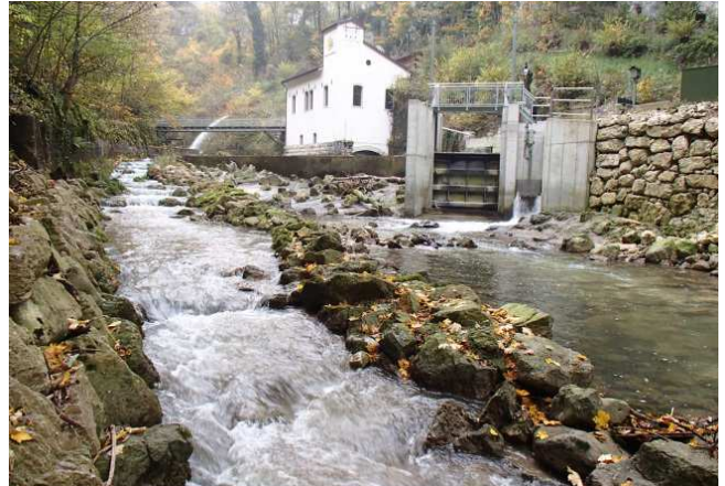
Raugerinne, Schüss bei Bözingen (Zentralen Nr. 51043)
