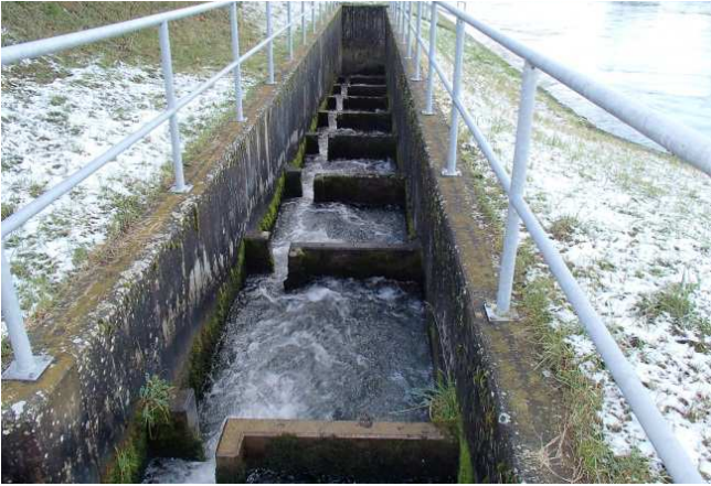
Schlitzpass, Aare bei Niederried (Zentralen Nr. 13028)
