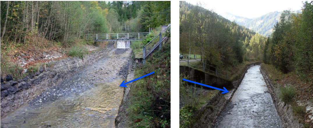
Abbildung 6: Wasserrückgabe des KW Innergsteig (blauer Pfeil), links ab Rückgabe aufwärts mit hoher Schwelle, rechts ab Rückgabe abwärts mit gepflasterter Sohle.
