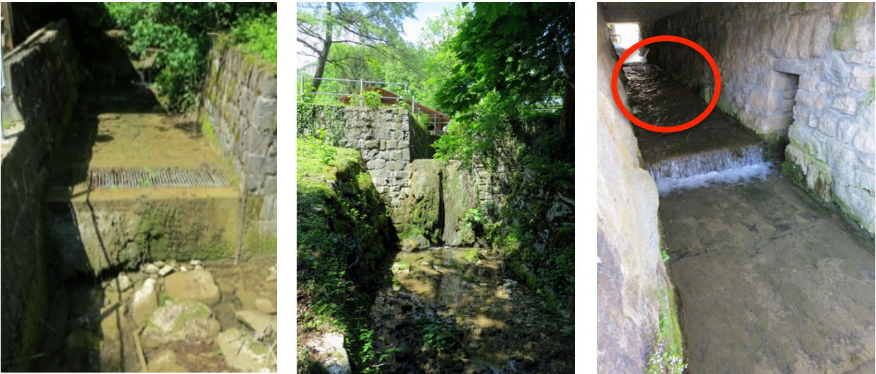
Abbildung 12: „Fassungsbauwerk“ für den Mühleweiher Oberbipp, das Wasser wird oberhalb einer hohen Schwelle (Mitte) in den Weiher abgeleitet (links) und Wasserrückgabe unter einem Haus im Dorf (rechts).
