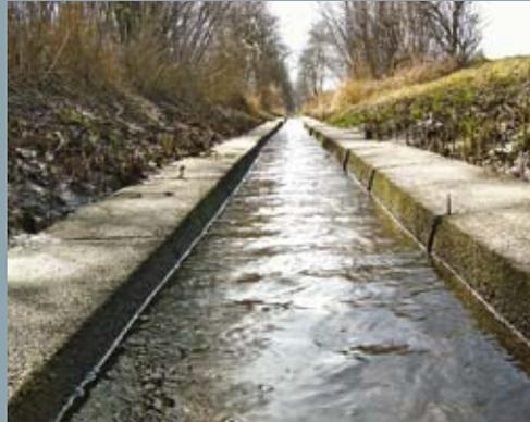
Wegen der geringen Grabengefälle mussten die Kanalsohlen mit Brettern verkleidet werden, um eine schnelle Verkräutung der Gerinnesohlen zu verhindern. Die seitliche Begrenzung bilden üblicherweise zwei Randsteine, die auf Holztraversen stehen, auf denen der Bretterboden fixiert ist. Diese Grabensteine haben sich bis heute als zweckmässig erwiesen. Die geometrische Form erleichtert die für die Erhaltung der Funktionsfähigkeit wichtige Sohlenreinigung.
