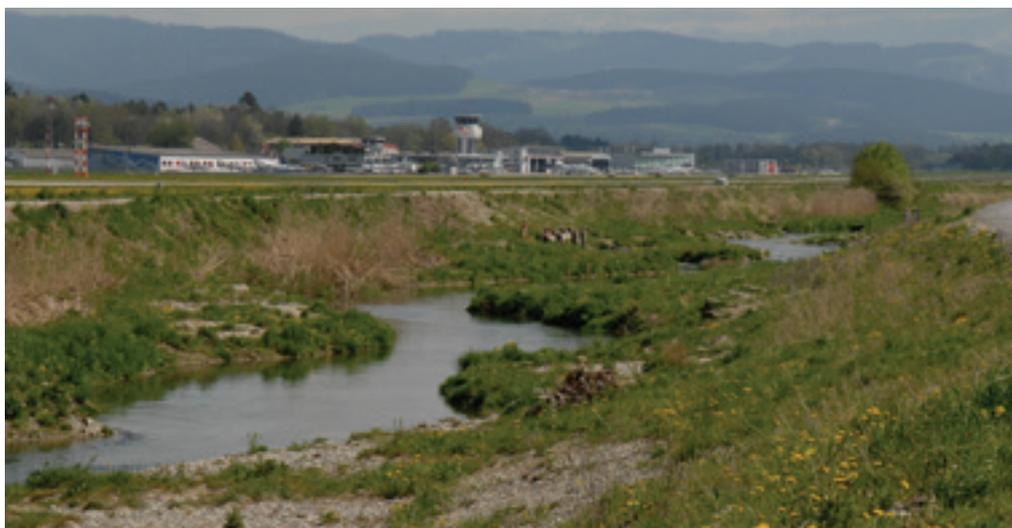
Um den Flughafen besser vor Überschwemmungen zu schützen, hat man das Flussbett der Gürbe im Raum Belpmoos deutlich aufgeweitet und die Dämme erhöht. Im Zuge der vorgezogenen Hochwasserschutzmassnahmen ist zugleich auch der Flusslebensraum ökologisch aufgewertet worden.
