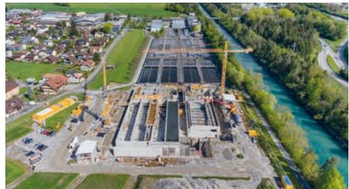
Zum Schutz der Gewässer vor organischen Spurenstoffen werden insbesondere grosse Kläranlagen mit einer weiteren Reinigungsstufe ausgerüstet. Messungen in ARA-Abläufen vor dem Ausbau zeigen auf, welche Frachten es künftig zu reduzieren gilt. **Seite 27**
