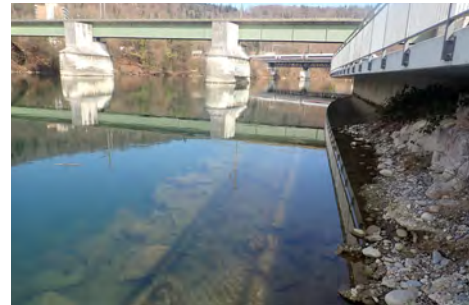
Ufer rechts (Blick abwärts)
