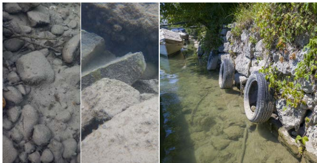
Weitgehend grobes, teils stark mit Algen bewachsenes Substrat direkt am Uferverbau des rechten Ufers.
