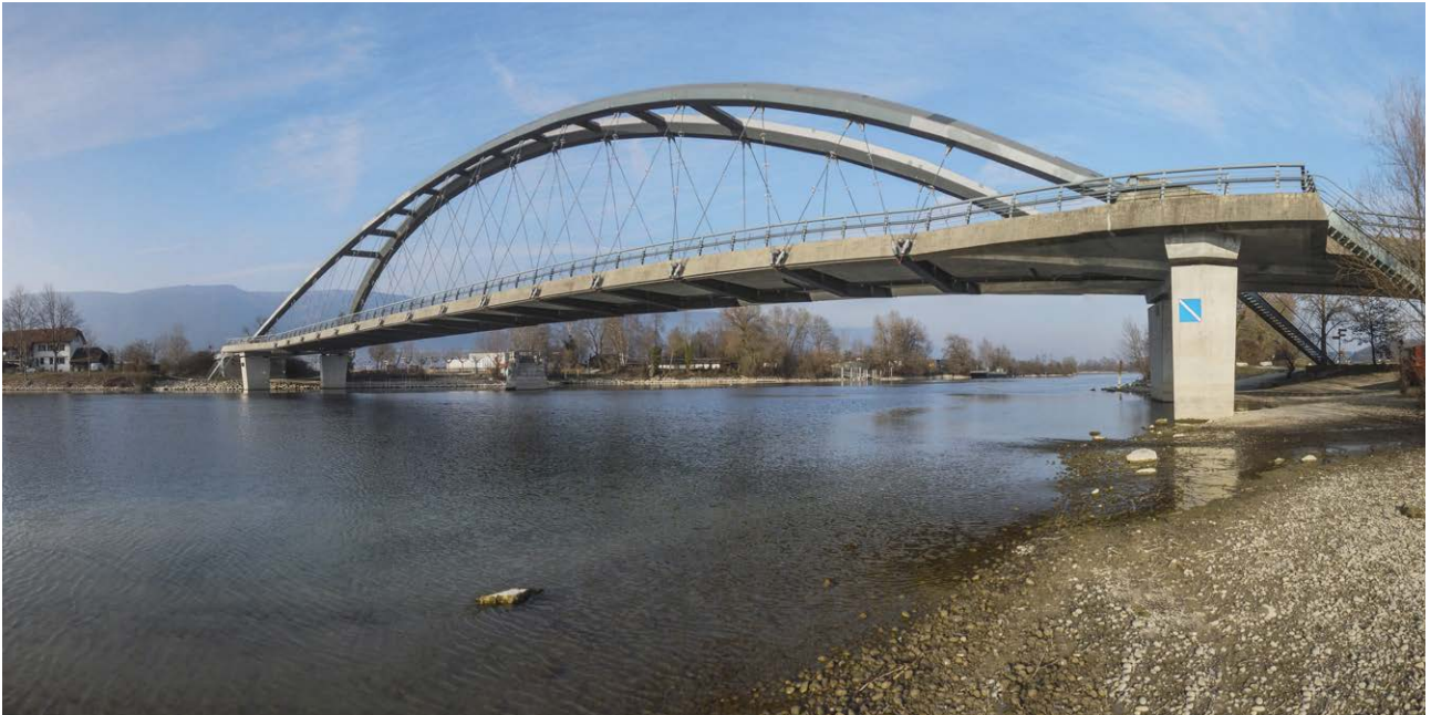
Aare bei Strassenbrücke Arch flussabwärts betrachtet.
