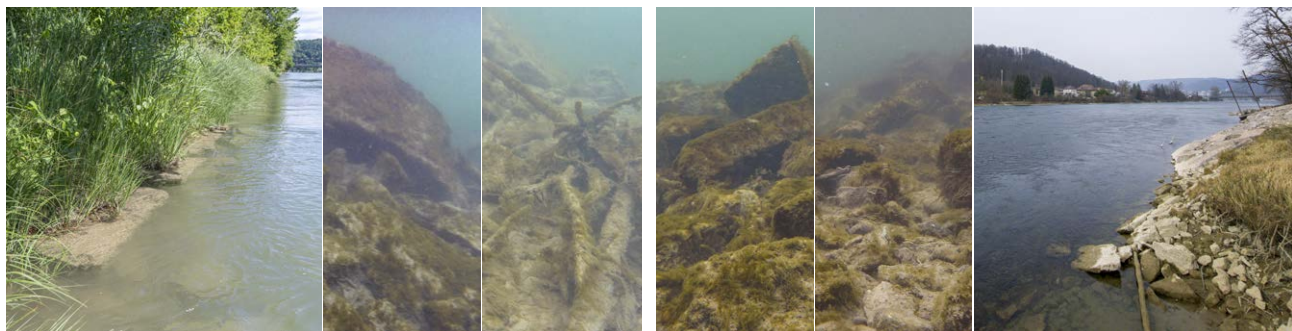
Überwiegend mit Algen bewachsener Uferverbau mit teilweise etwas Totholz und Feinsediment am linken Ufer.
