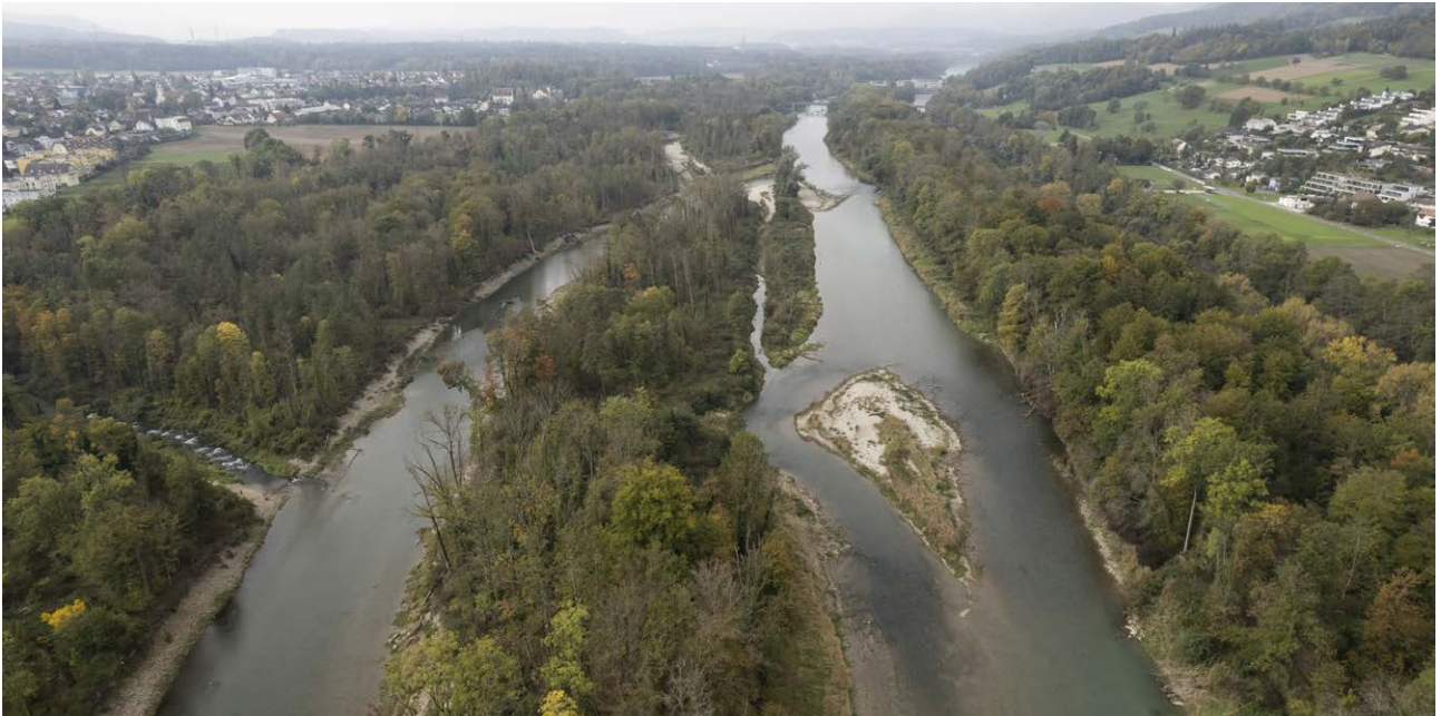
Restwasserstrecke der Aare bei Rapperswil-Auenstein flussaufwärts betrachtet.
