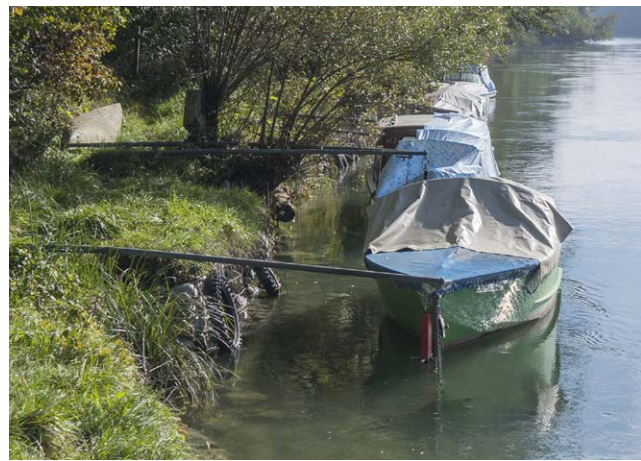
Steiler Uferverbau mit Boots-liegeplätzen und entsprechenden technischen Einrichtungen am rechten Ufer.
