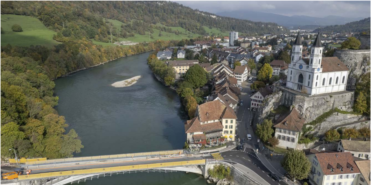
Aare bei Aarburg bei leicht erhöhtem Wasserstand flussabwärts betrachtet.
