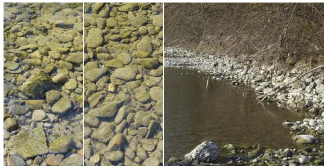
Überwiegend Steine im Nebenarm rechts, der im März nicht durchflossen war. Landseits steiler Uferanriss.
