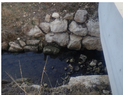
Uferverbauung Natursteine locker bei Brücke
