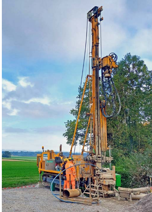
Probebohrung im unteren Emmental zur Erschliessung von ergiebigen und möglichst wenig belasteten Trinkwasserressourcen.
