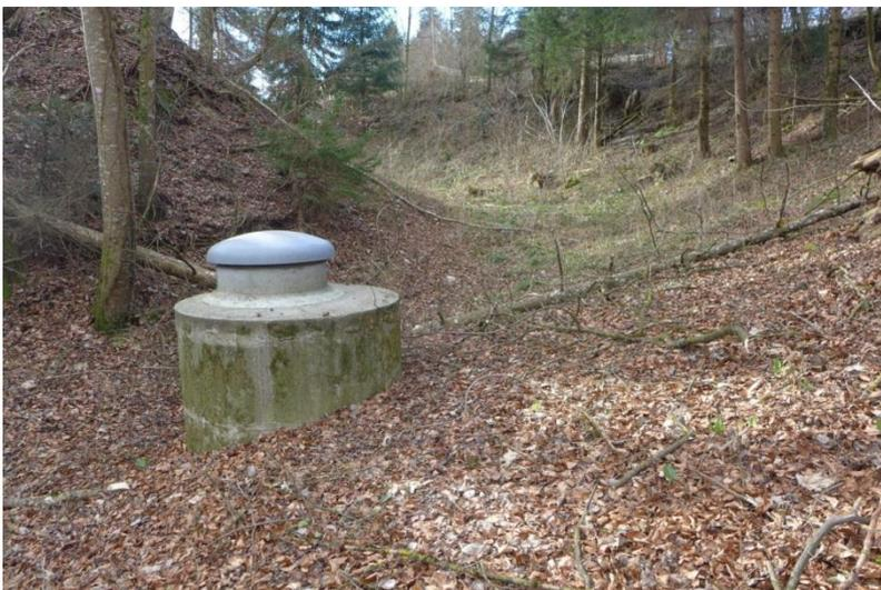
Abbildung 3: Die Quelle ist komplett gefasst ohne jeglichen Überlauf. So kann sich kein Quelllebensraum bilden und die Quelle gilt als zerstört. (QBB923, Kehrsatz BE)
