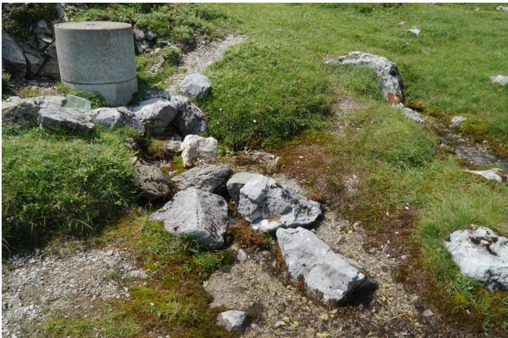
Abbildung 12: Fassungstyp Brunnenstube mit Überlauf. Eine neuere Brunnenstube ohne jegliche Vegetation. Der Überlauf fließt relativ naturnah ab. (QBO875, Adelboden BE)
