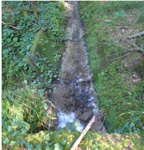
Abbildung 20: Die Gewässersohle ist vom Austritt an stark verbaut. Die Bildung von Kleinhabitaten wird so gestört. (QAA628, Schüpfen BE)
