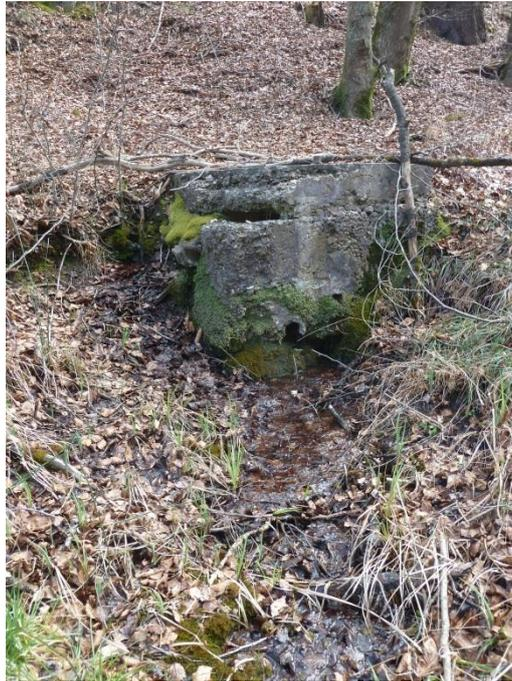
Abbildung 13: Fassungstyp Brunnenstube mit Überlauf. Eine Brunnenstube welche schon so stark verfallen ist, dass ein grosser Teil des Wassers normal abläuft. (QAA147, Bern BE)
