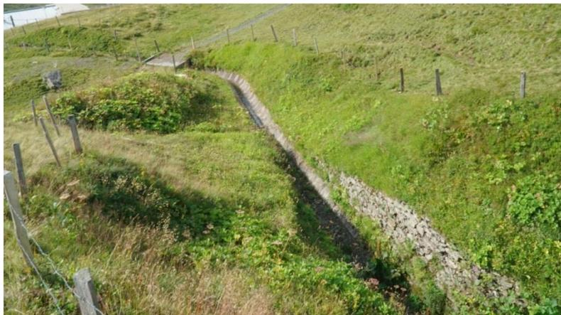
Abbildung 21: Auch hier ist der gesamte Quellabfluss verbaut. Die Bildung von Kleinhabitaten wird so gestört. (QBO900, Lauterbrunnen, BE)
