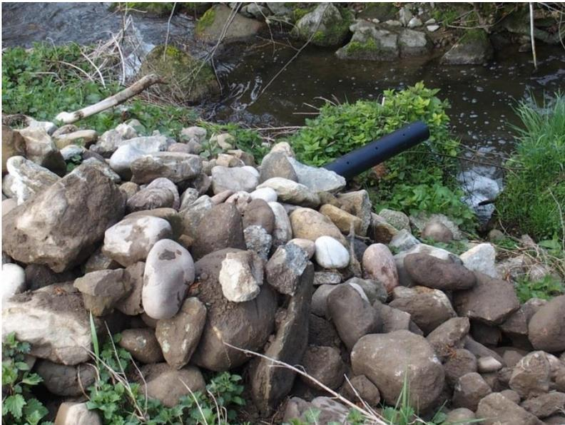
Abbildung 2: Der künstliche Quellaustritt leitet das Wasser direkt in einen Bach ein. So kann sich kein Quelllebensraum bilden und die Quelle gilt als zerstört. (QBA014, Arni BE)
