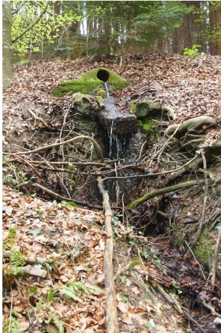
Abbildung 15: Fassungstyp Nur Rohr. Das Wasser tritt direkt aus einem Rohr aus. (QBB439, Köniz BE)
