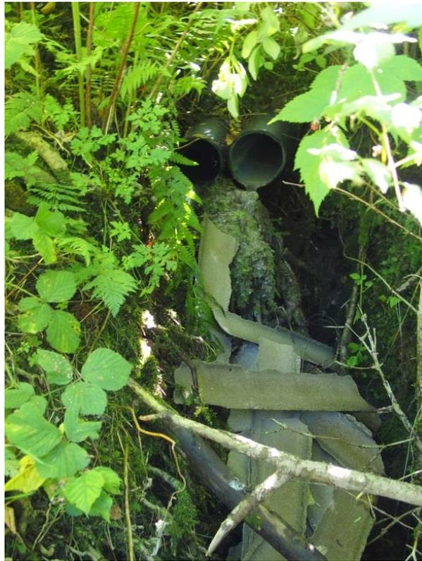
Abbildung 25: Bauschutt wurde direkt beim Austritt deponiert. (QBA721, Oberthal BE)
