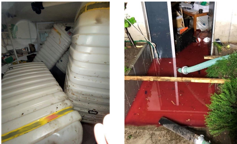
Abbildung 1: Links: Umgekippte Kunststoff-Tanks nach einem Hochwasserereignis. Rechts: Überfluteter Keller mit ausgelaufenem Heizöl (erkennbar durch die rote Färbung).
