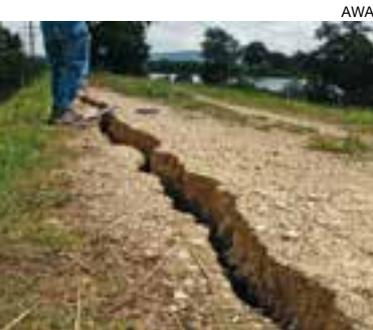
Gleich mehrfach in neuerer Zeit, nämlich in den Jahren 1999, 2005 (Foto oben) und 2007, hatten Hochwasser die bauliche Struktur des mittlerweile mehr als einhundert Jahre alten Hagneckkanals bis an die Grenzen der Belastbarkeit beansprucht.
