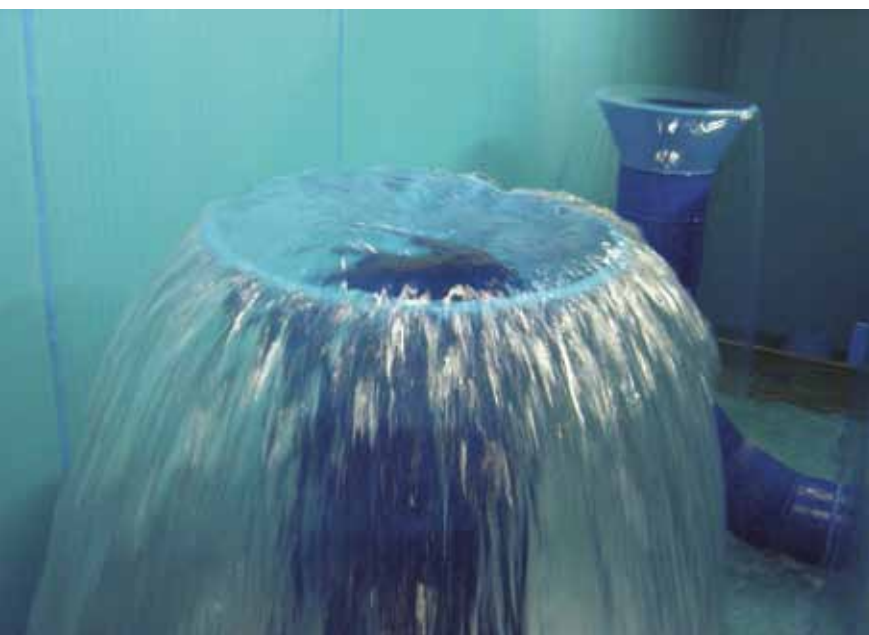
Abbildung 5: Die Wasserversorgung im Kanton Bern hat ein hohes Niveau. Optimierungen der Infrastruktur und der Organisationsstrukturen tragen zur langfristigen Sicherung bei. (Bild: AWA)
